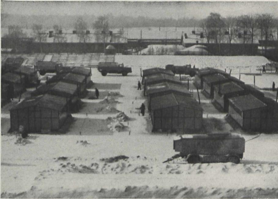
Bild 3. Dieses ganze Barackendorf des Bereitschaftslazarettes kann auf 8 Lastzügen untergebracht werden. Es umfaßt 400 Krankenbetten mit allem erdenklichen Zubehör. Auch von jeder fremden Strom-, Gas- und Wasserversorgung ist das Lazarett unabhängig
