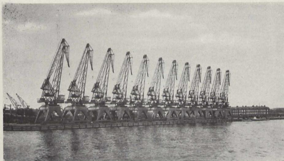
Bild 7. Eine Ausfuhrlieferung von 12 Hafenkranen nach Schweden. Die Krane sind weitgehend in geschweißter Stahlbauweise ausgeführt. Die Triebwerke (Hubwerk, Drehwerk, Einziehwerk und Fahrwerk) sind in vollständig gekapselter Bauweise durchgebildet, so daß man auf ein besonderes Maschinenhaus verzichten konnte
