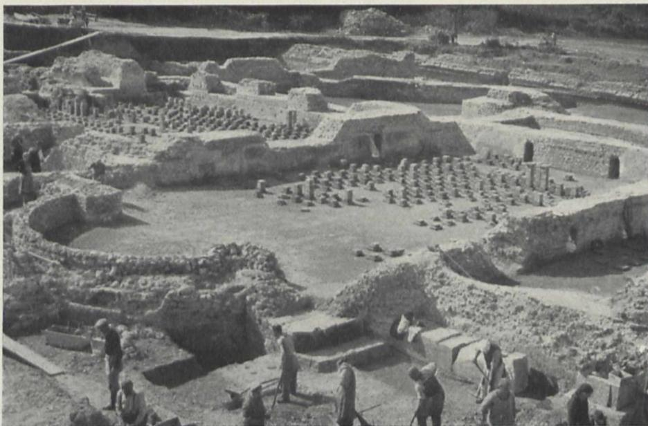
Bild 1. Blick auf einen der großen Räume innerhalb der Siedlung Carnuntum, von denen einige Ausmaße bis zu 12 × 22 m erreichen. Die in großer Fülle sichtbaren Pfeiler tragen die Platten des Fußbodens, der von unten beheizt wurde
