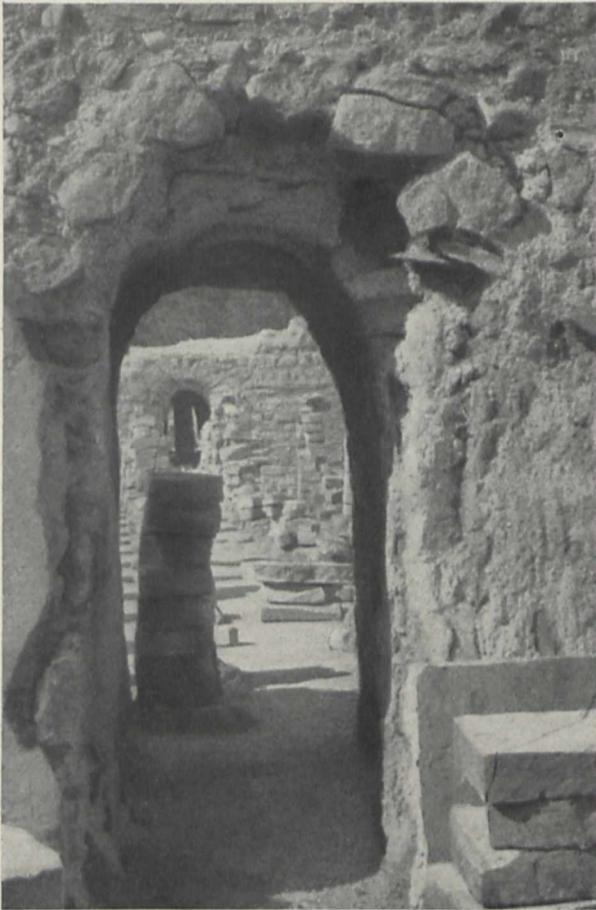
Bild 3. Heizgang, der dem in Bild 1 wiedergegebenen Raum die Heißluft zuführte
