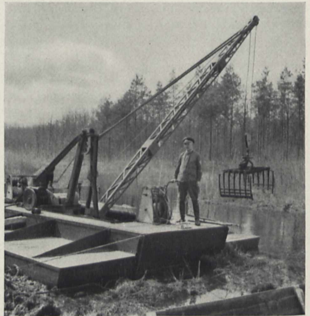
Bild 2. Greiferkran für Entlandungsarbeiten
