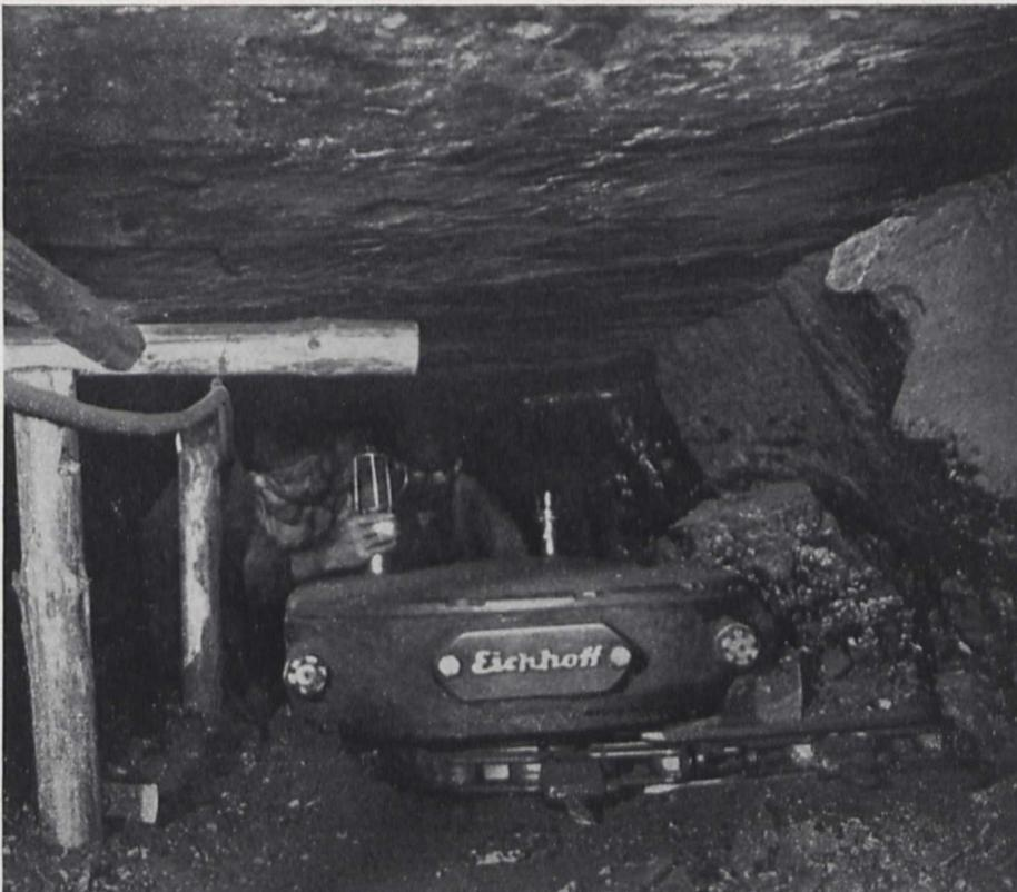
Bild 3. Schrämmaschine in geringmächtigem Anthrazitkohlen-Flöz
