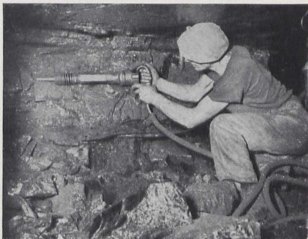
Bild 1. Hauer vor Ort mit einem preßluftbetriebenen Abbauhammer
