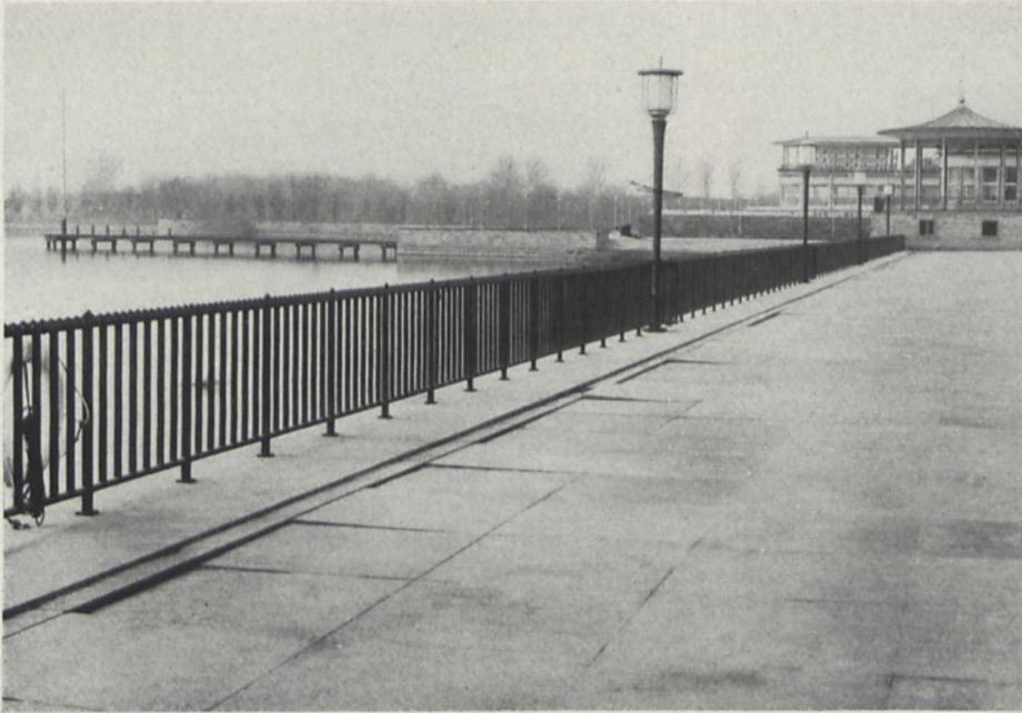
Bild 7. Beschädigungen eines Steinplattenganges am Uferrand durch starken Frost des letzten Winters
