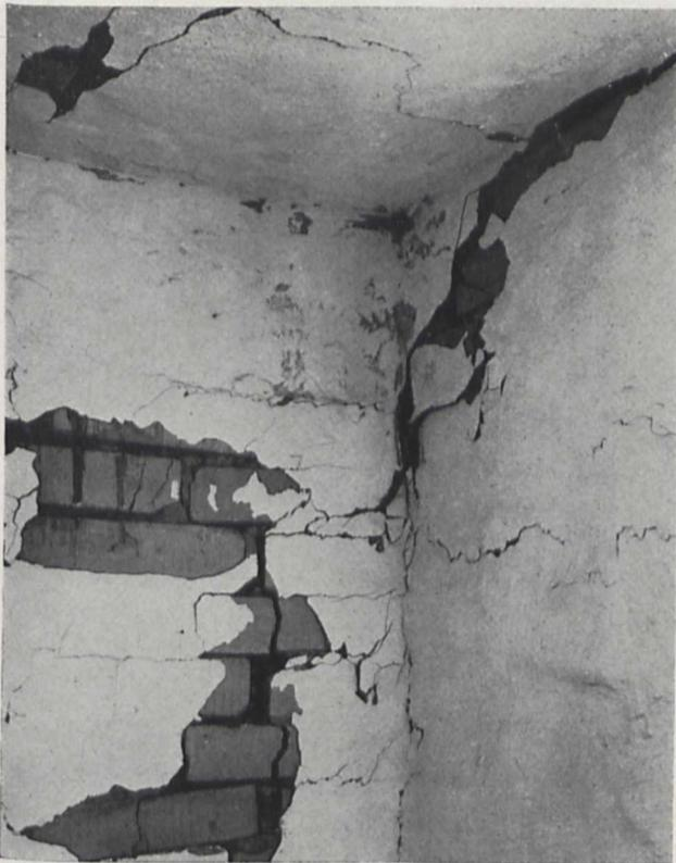
**Bild 5.** In den Wandecken sind die Zerstörungen naturgemäß am größten, desgleichen am Anschluß der Decken
