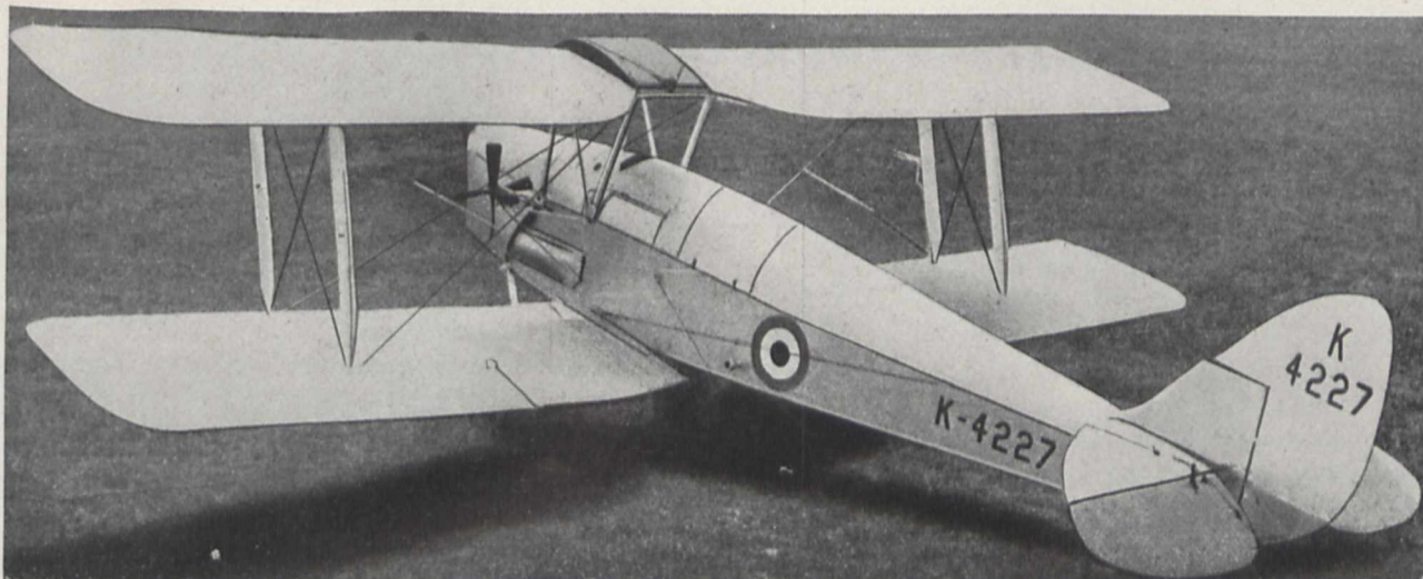
Bild 2. Funkgesteuertes Zielflugzeug De Havilland „Queen Bee“ mit 130 PS De Havilland „Gipsy Major“-Motor
