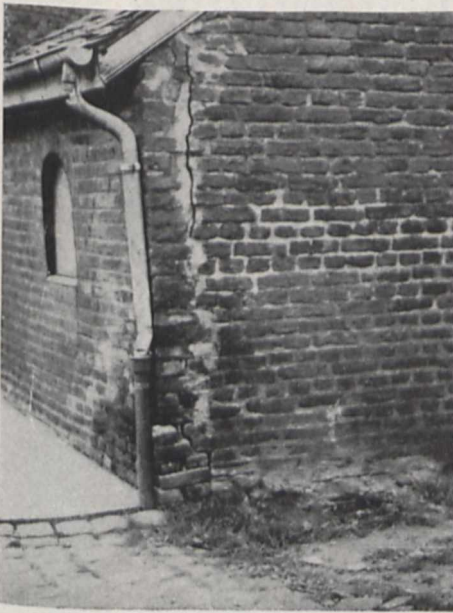
Bild 8 (links). Das Regenwasser durchfeuchtet das Erdreich und läßt die Wand absacken
