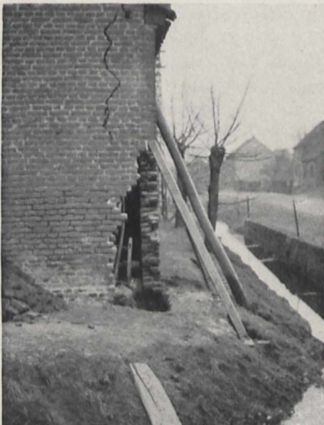
Bild 2 (links). Ein Haus am Bach hatte so stark unter der Senkung gelitten, daß die Ecken weggebrochen und erneuert werden mußten
