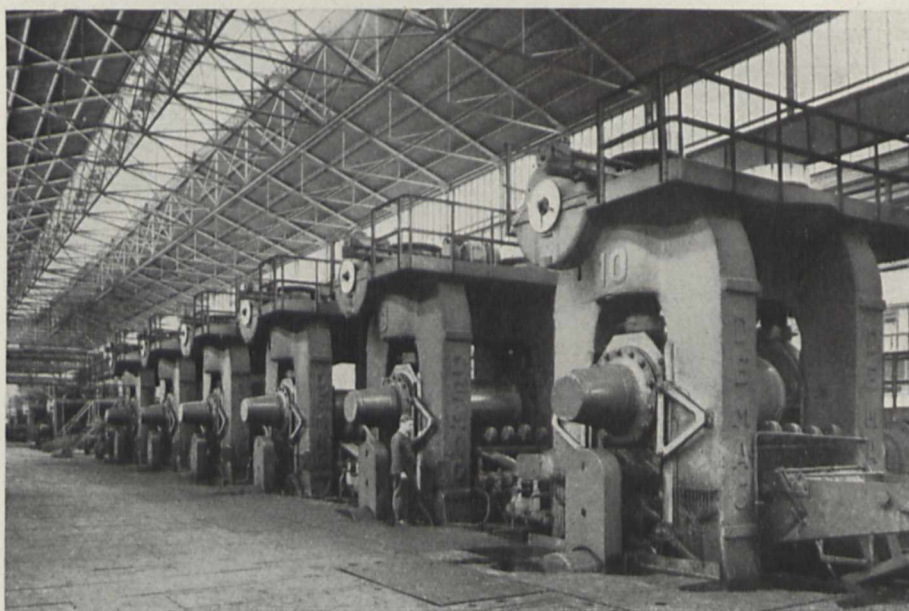
Bild 2. Auslaufseite einer sechsgerüstigen Vierwalzen-Fertigstraße
