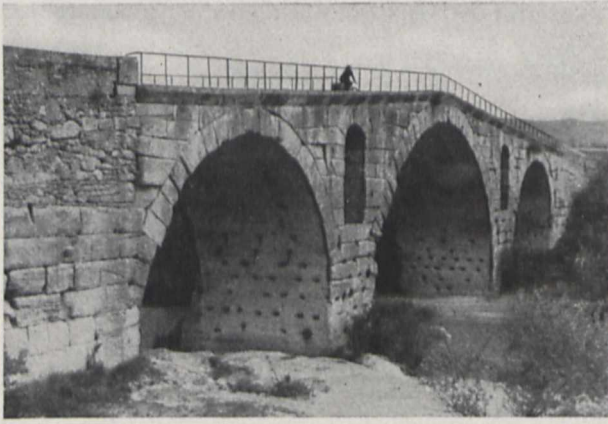
Bild 3. Pont Julien, 68 m lang und 14 m hoch ohne Mörtel über den Coulon-Fluß erbaut
