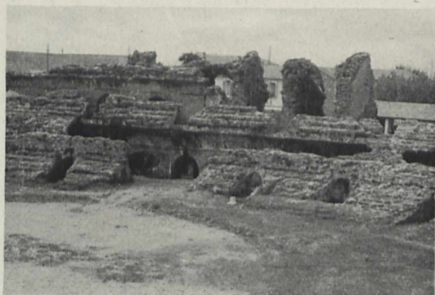
Bild 2. Reste des römischen Amphitheaters in Fréjus. Die gewaltigen Gewölbe unter den Sitzreihen dienten als Verbindungsgänge
