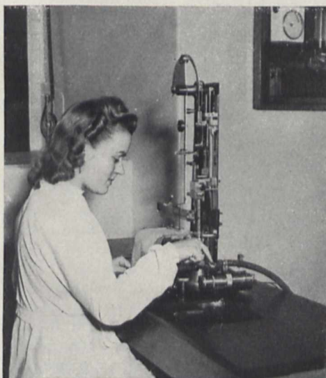
Bild 9. Faserprüfung im Klimaraum
