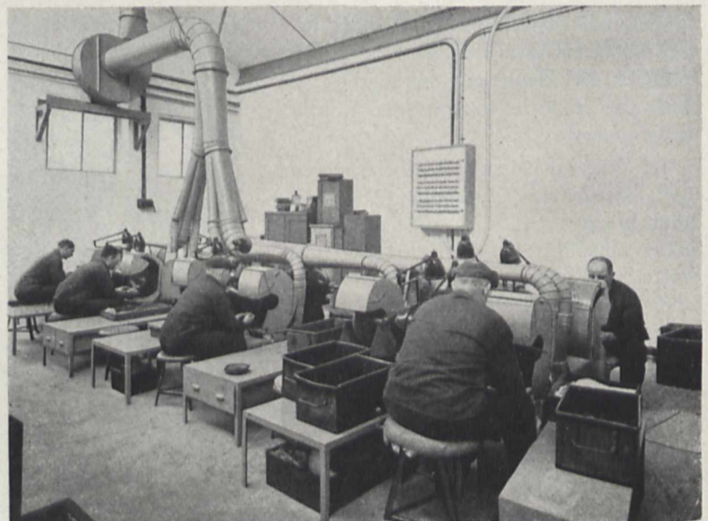
Bild 5. Absaugen und pneumatischer Transport von Schleifstaub
