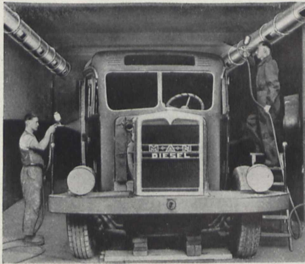
Bild 4. In einer Auto-Lackiererei wird der Farbnebel abgesaugt und Warmluft zugeführt
