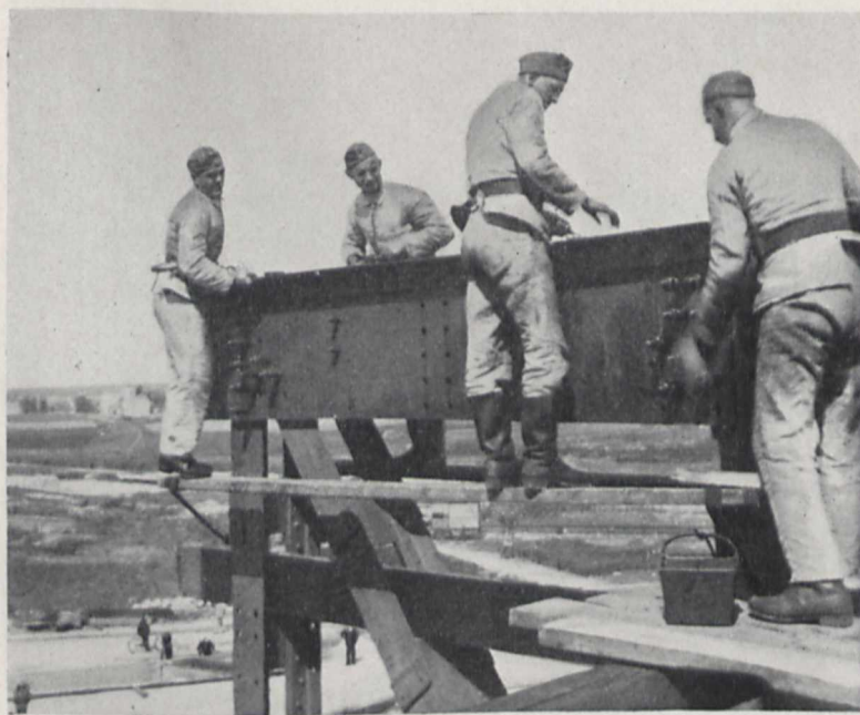
Bild 7. Eisenbahnpioniere bei der Montage einer Fachwerkbrücke aus vorbereitetem Kriegsbrückengerät
