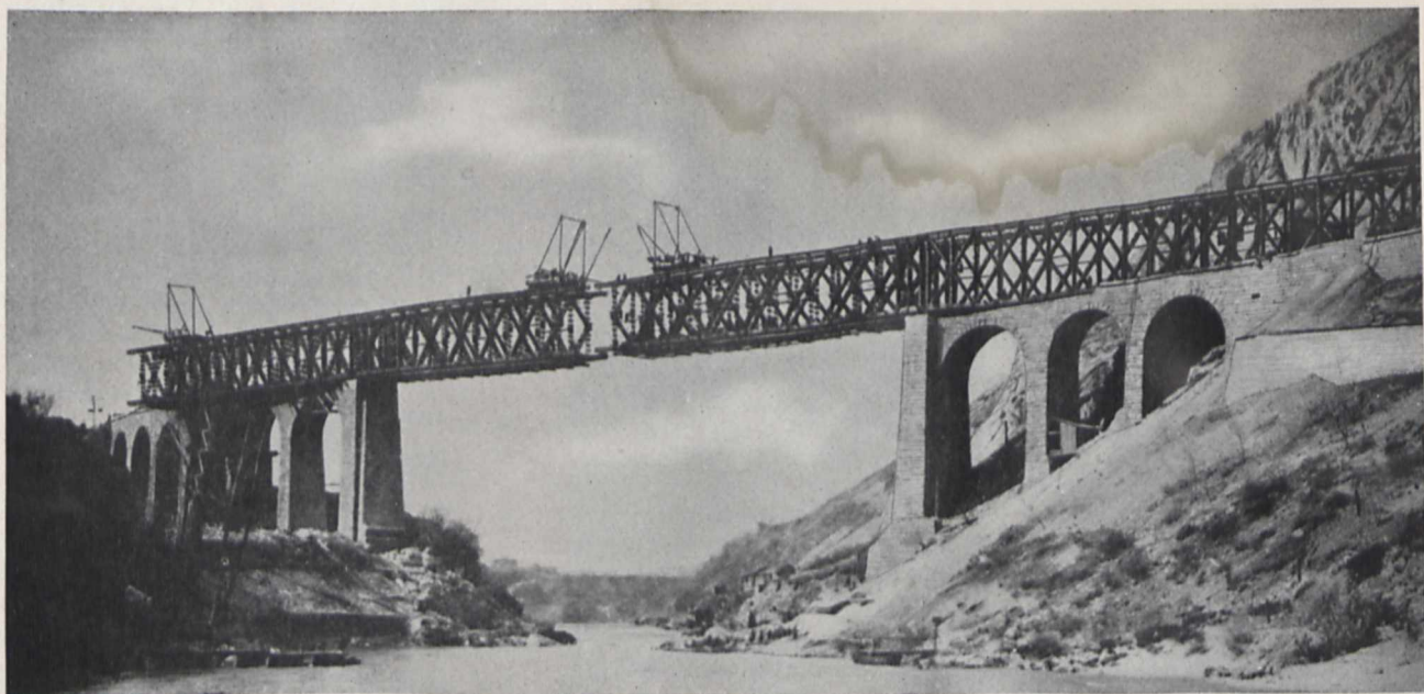
Bild 6. Freier Vorbau einer Kriegsbrücke.
