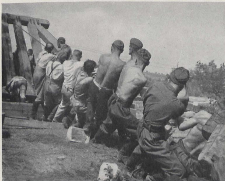
Bild 3. Aufrichten eines hölzernen Schwelljoches für eine Unterstüttzung. Menschenkraft muß die Hebezeuge ersetzen
