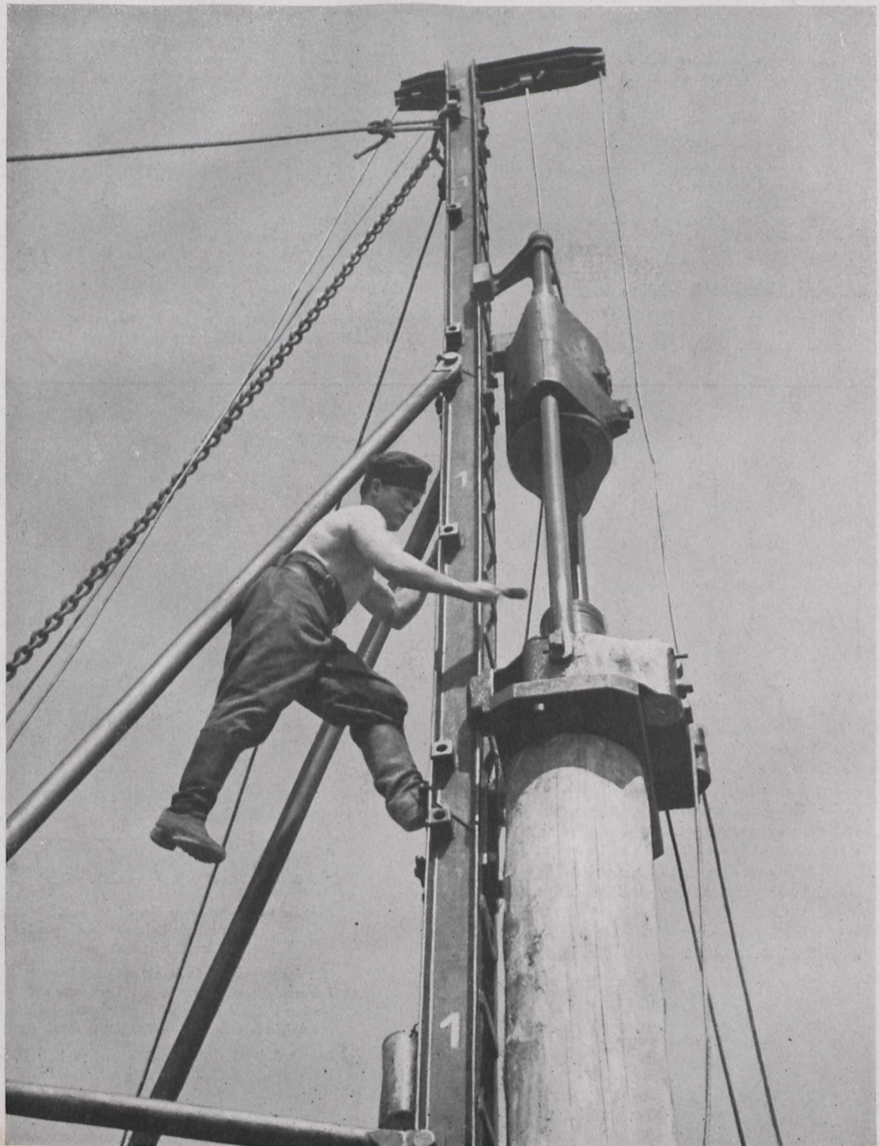
Eisenbahn Pioniere beim Bau einer Kriegs- brücke
