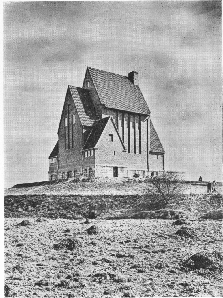
Krematorium vom Vorwerker Friedhof in Lübeck.
