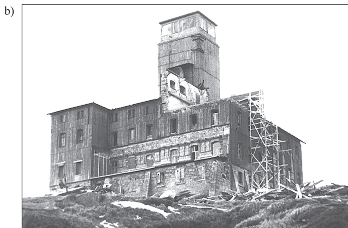
Ryc. 9. Budynek w 1965 r. (a); budynek w 1975 r. widziany od północy; rozbiórka kondygnacji dla tzw. pola antenowego (b) (fot. B. Chęć)
