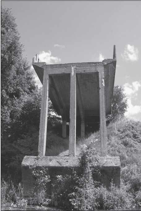
Ryc. 18. Wschodni przyczółek mostu (fotografia ze zbiorów własnych autora)
