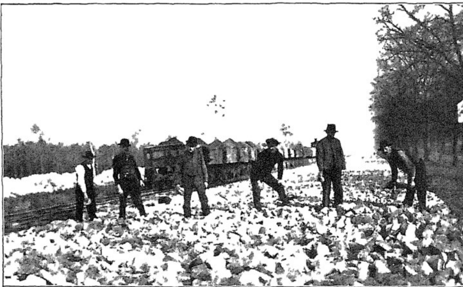
Abb. 1. — Automobilstraße im Grunewald. Herstellung des Untergrundes.
