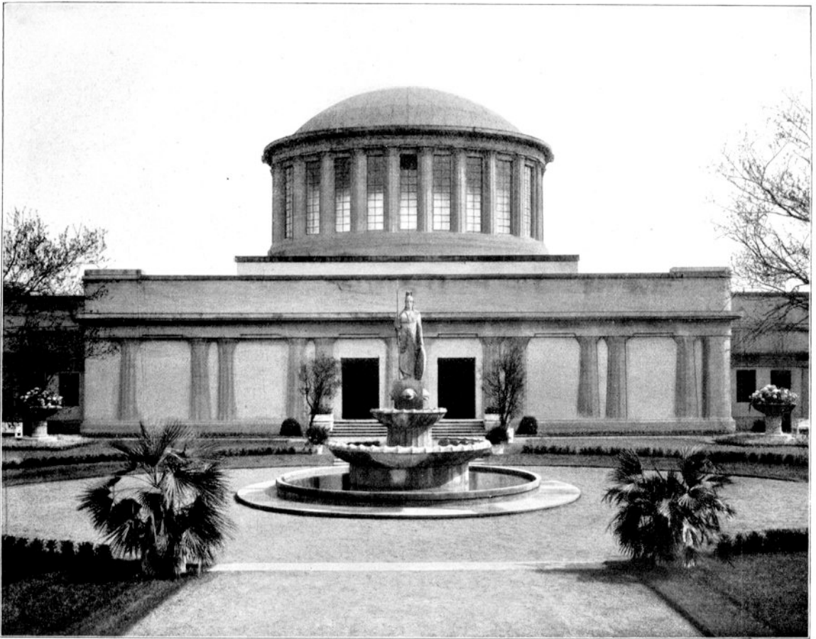
Gartenhof im Gebäude der historischen Ausstellung
