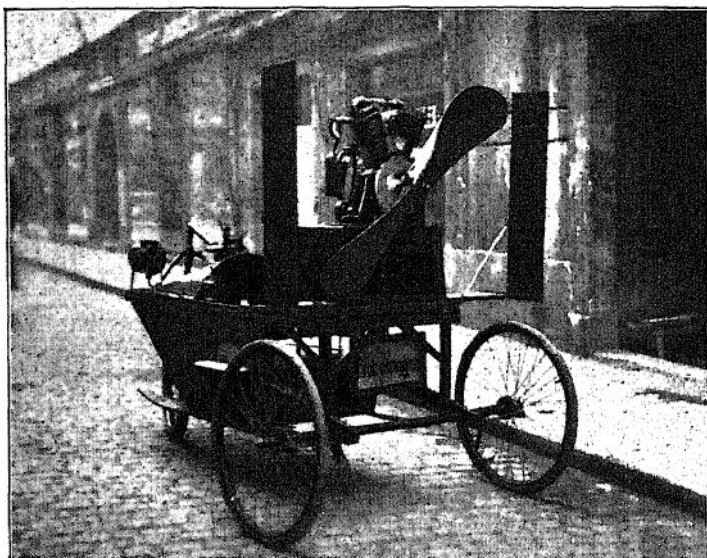
Motor-Dreirad mit Propeller-Antrieb. Ein neuartiges Verkehrsmittel im Zeichen der Verkehrsnot.
