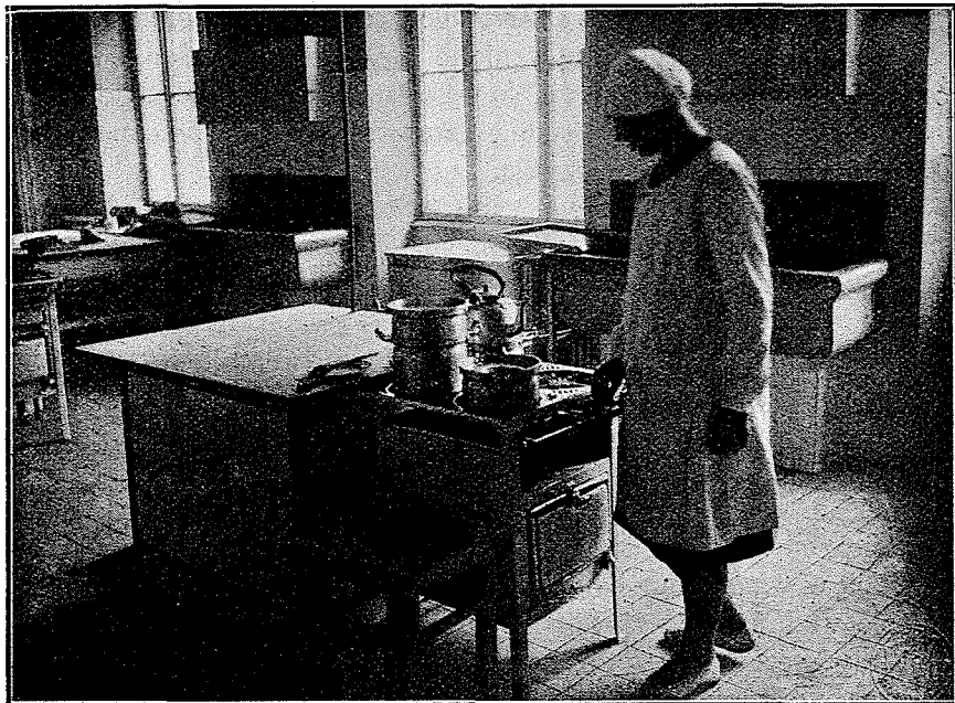
Ryc. 3. Piec węglowy i gazowy, zastosowany w Państw. Seminarjum Gospodarczym w Krakowie. (W okresie używania kuchni gazowych powierzchnia pieca węglowego, zakryta pokrywą z desek, służy jako stół podręczny do wykończenia potraw).
