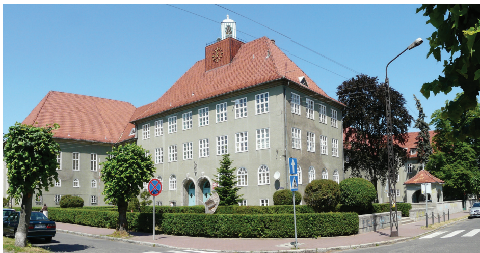
Il. 10. Budynek szkoły obecnie (fot. A. Lisowska)
