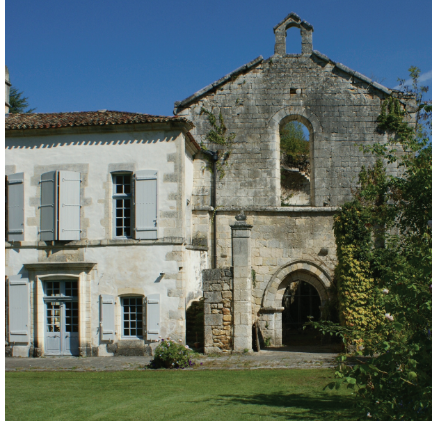
Il. 4. Elewacja zachodnia kościoła w Grosbot, 2012 (fot. E. Łużyniecka)
