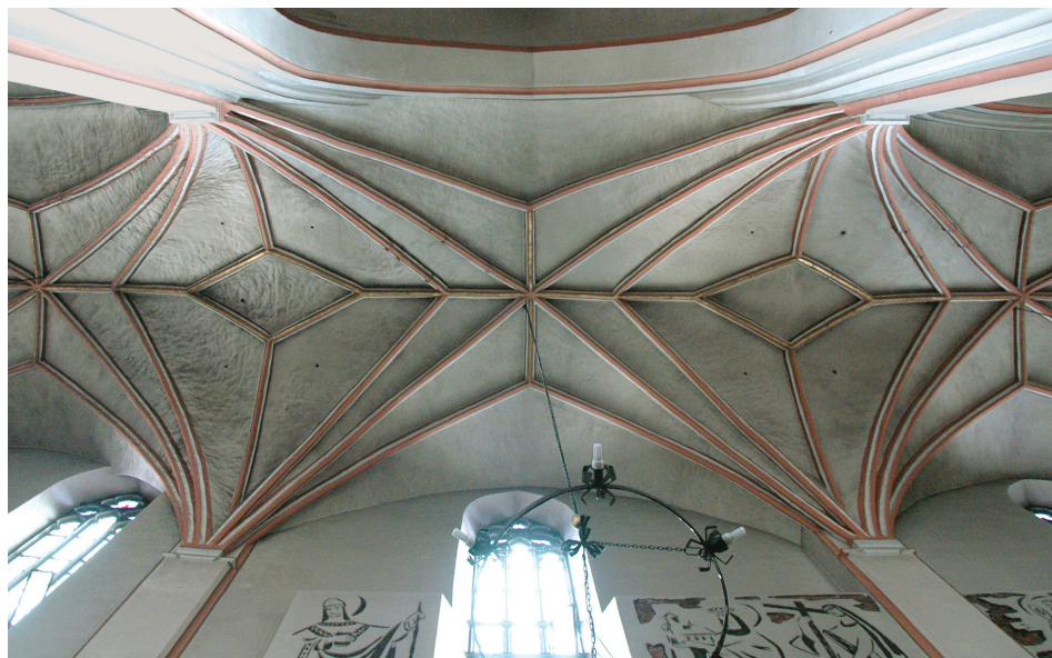
Il. 12. Opole – katedra, obniżone sklepienie nad nawą południową
