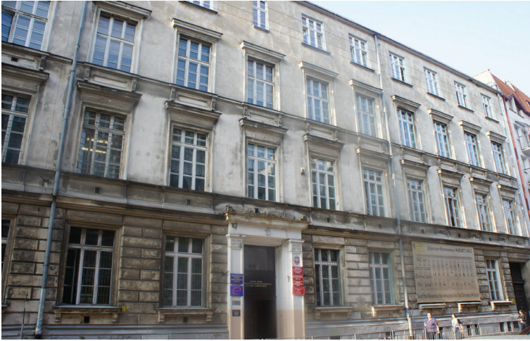
Fot. 3. Budynek mieszczący Zespół Szkół Ekonomiczno-Administracyjnych im. Marii Dąbrowskiej we Wrocławiu, do 1933 roku siedziba Gimnazjum św Jana Photo 3. A building housing Maria Dąbrowska Economics and Administration Schools, before 1933 Johannes Gymnasium
