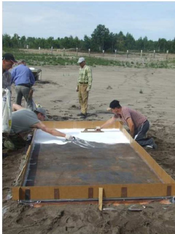
Rys. 6. Przygotowanie układu zgrzewania
