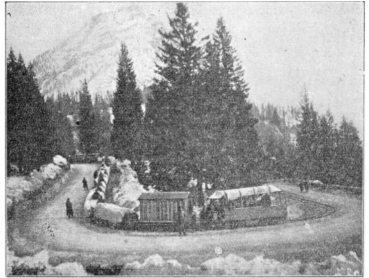
Abb. 4. — Durch Generatorwagen beförderter Militärzug. (Oe. D. M. A.-G., Wr.-Neustadt.)
