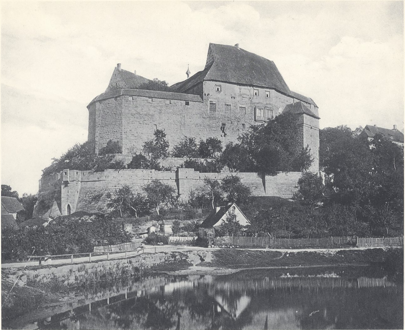
Abb. 1. Ansicht von Westen.
