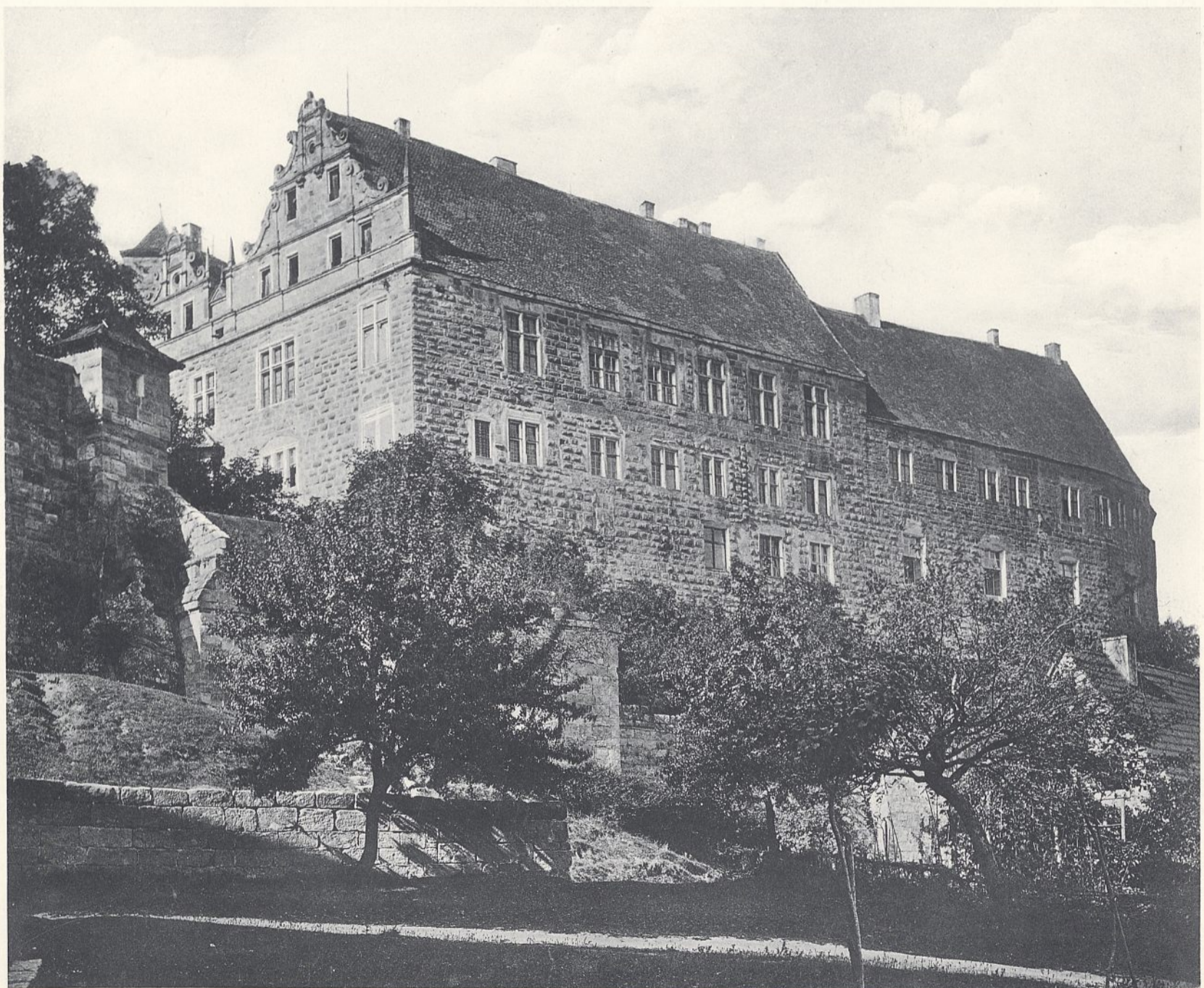
Abb. 2. Ansicht von Nordosten.
