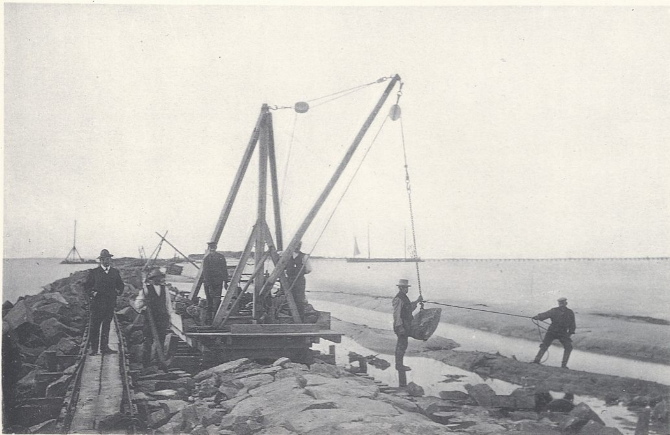
Abb. 3. Hölzerner Drehkran beim Bau der Mittelrippe auf der Insel Ruden.
