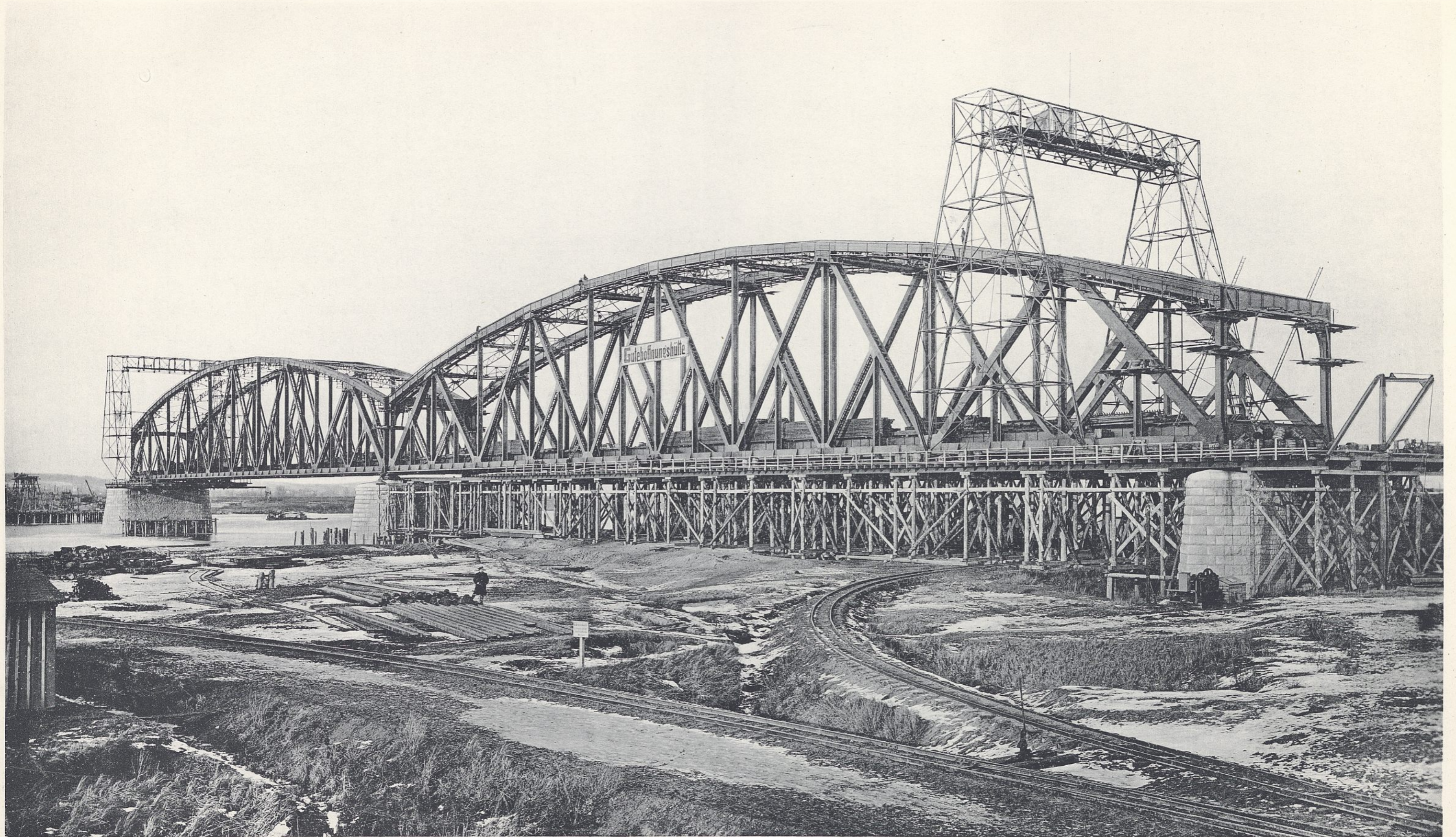
Aufstellung der Überbauten in den Öffnungen 6 u. 7.
