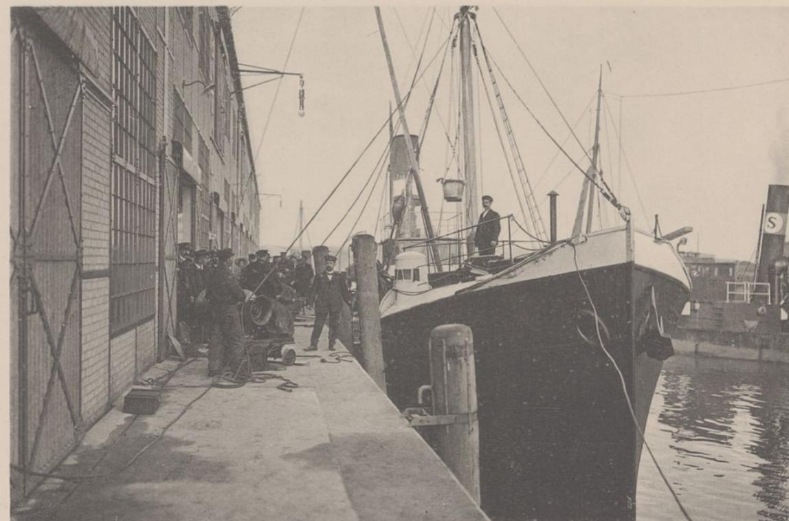
Abb. 4. Löschen eines Dampfers mit elektrischer Winde vor der neuen Versteigerungshalle.
