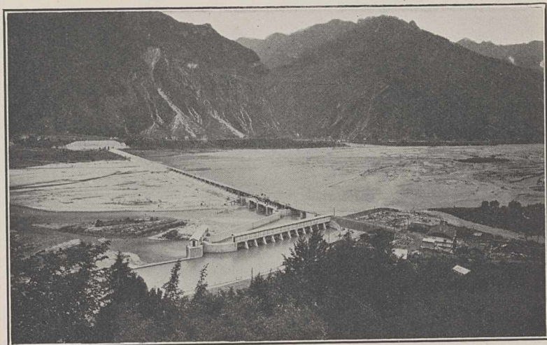
FIG. 1.—Piave and Santa Croce hydro-electric installation; dam and intake at the Piave. By courtesy of the Società per l'Utilizzazione delle Forze Idrauliche del Veneto.
