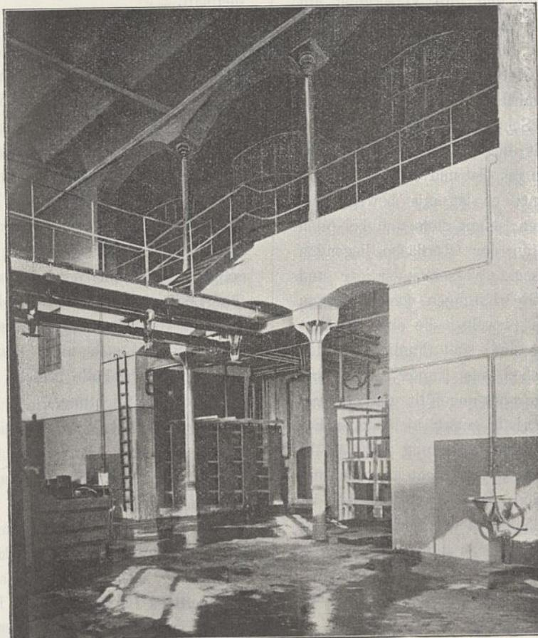
Abb. 2. Trockenkammer und Bottiche in der Schlammküche.
