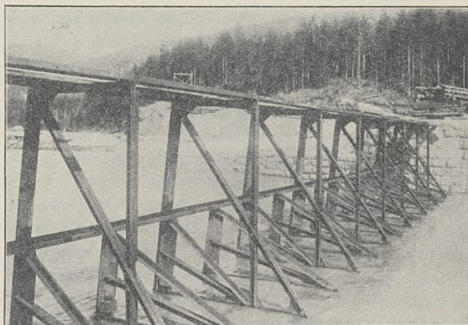
Abb. 27. Nadel- und Dammbalkenwehr beim Eidsfos (1898).
