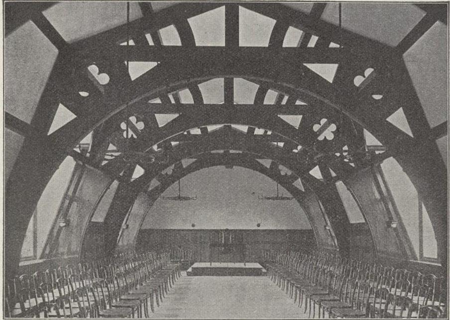
Abb. 86. Vortragssaal im Dachgeschofs des Nebengebäudes.
