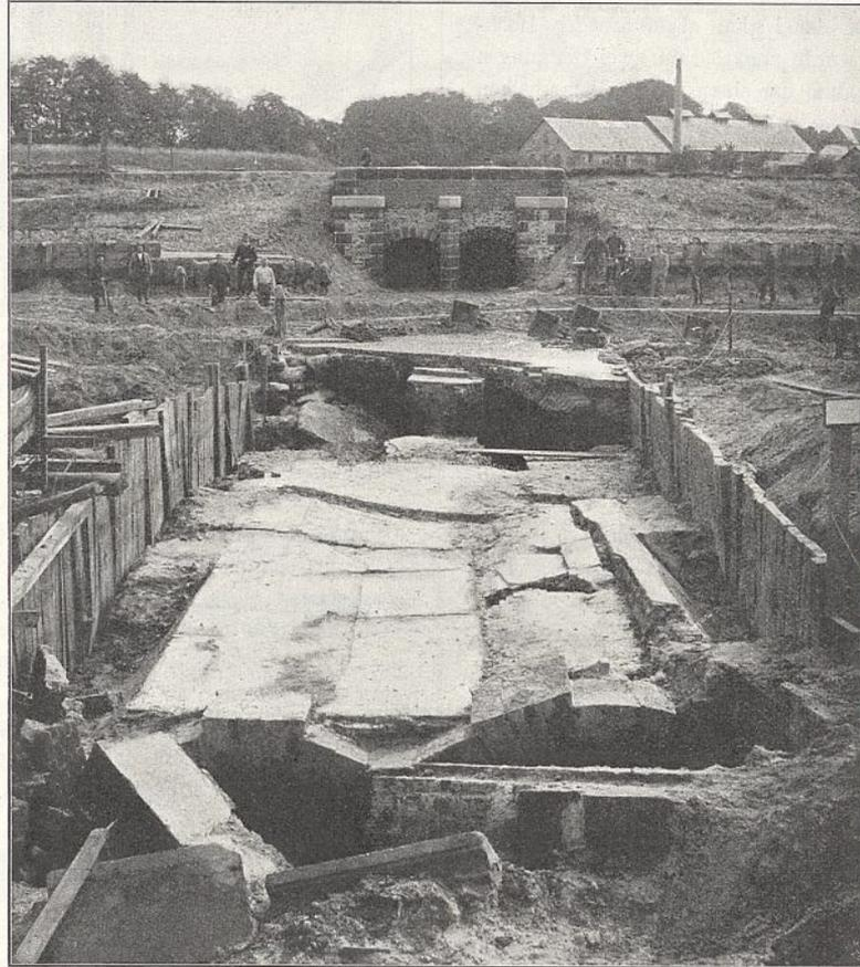
Abb. 78. Mühlbach-Düker nach dem Einsturz. September 1895.
