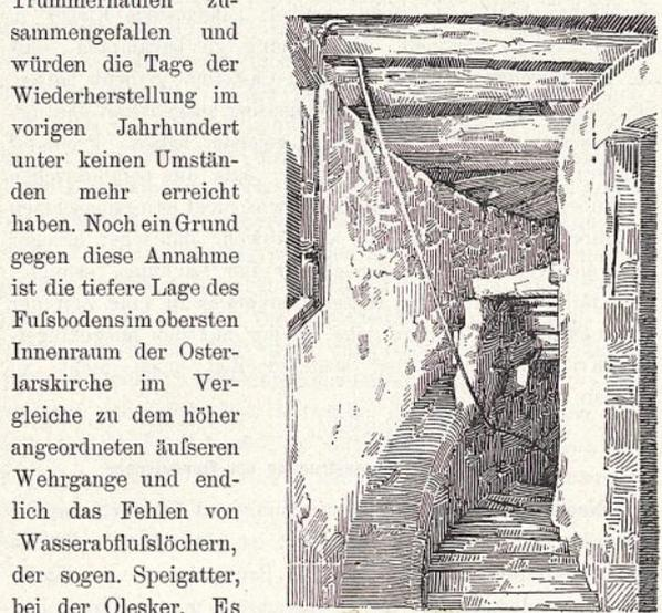
Abb. 22. Osterlarskirche. Austritt der Treppe im zweiten Obergeschofs mit den Ueberbleibseln seiner massiven Ueberdeckung.
