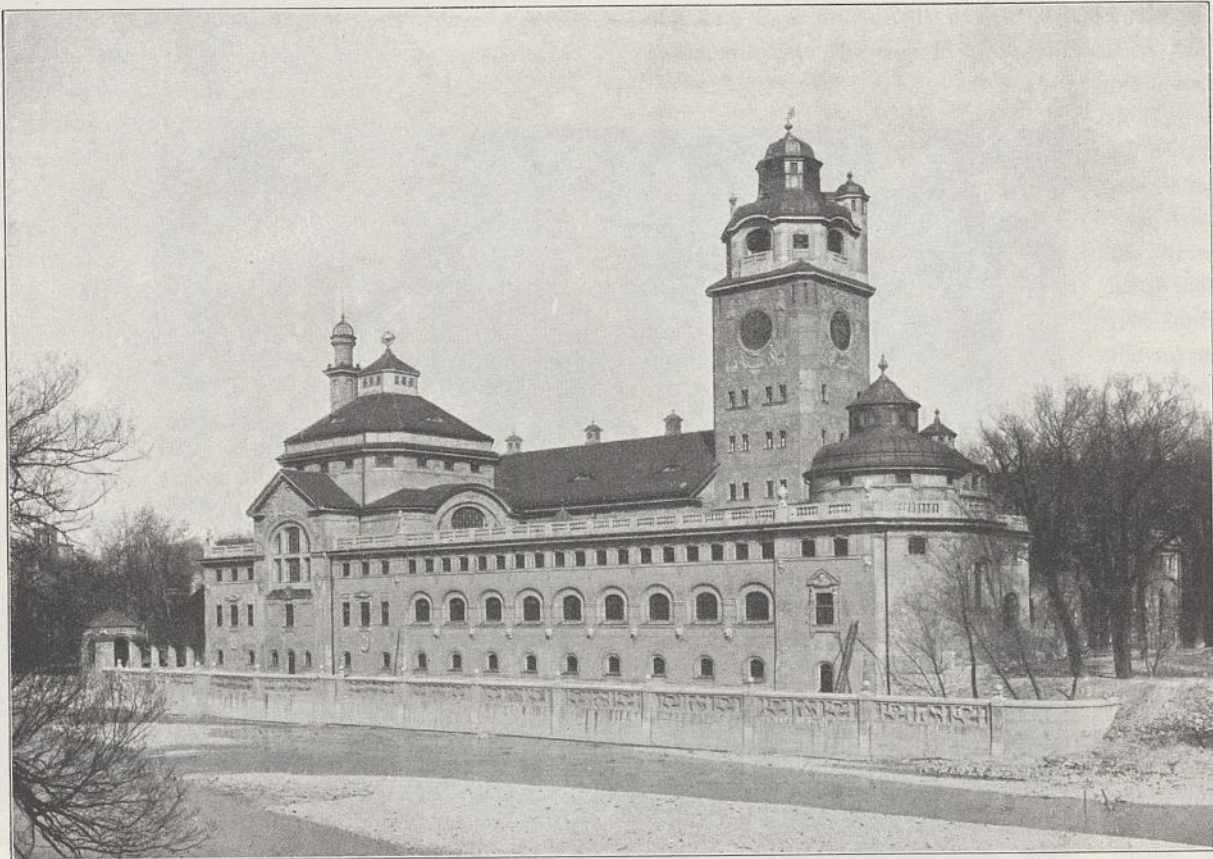
Abb. 4. Ansicht von Westen.
