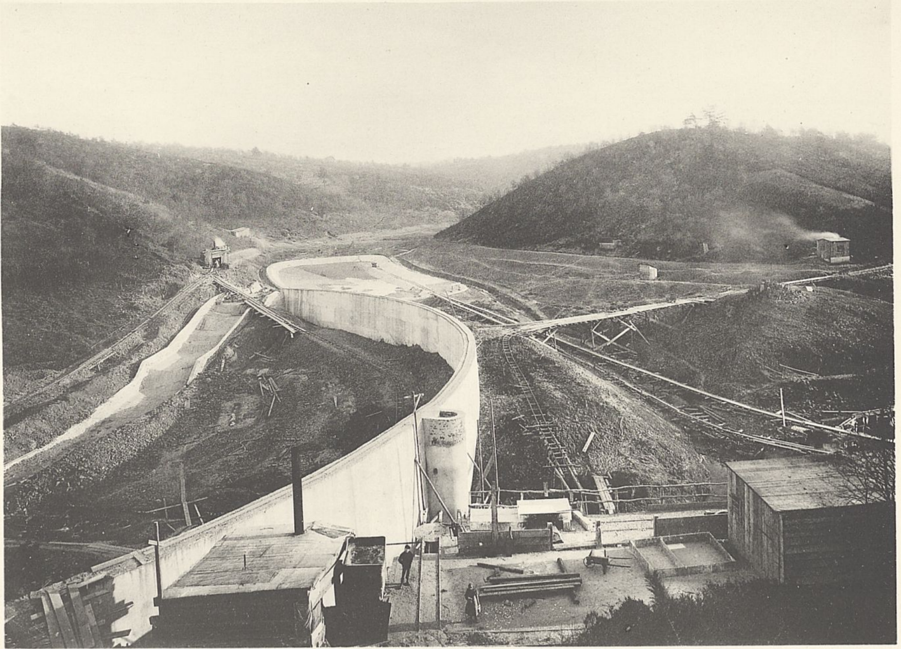
Abb. 1. Betonkern des Staudammes für das Vorbecken.
