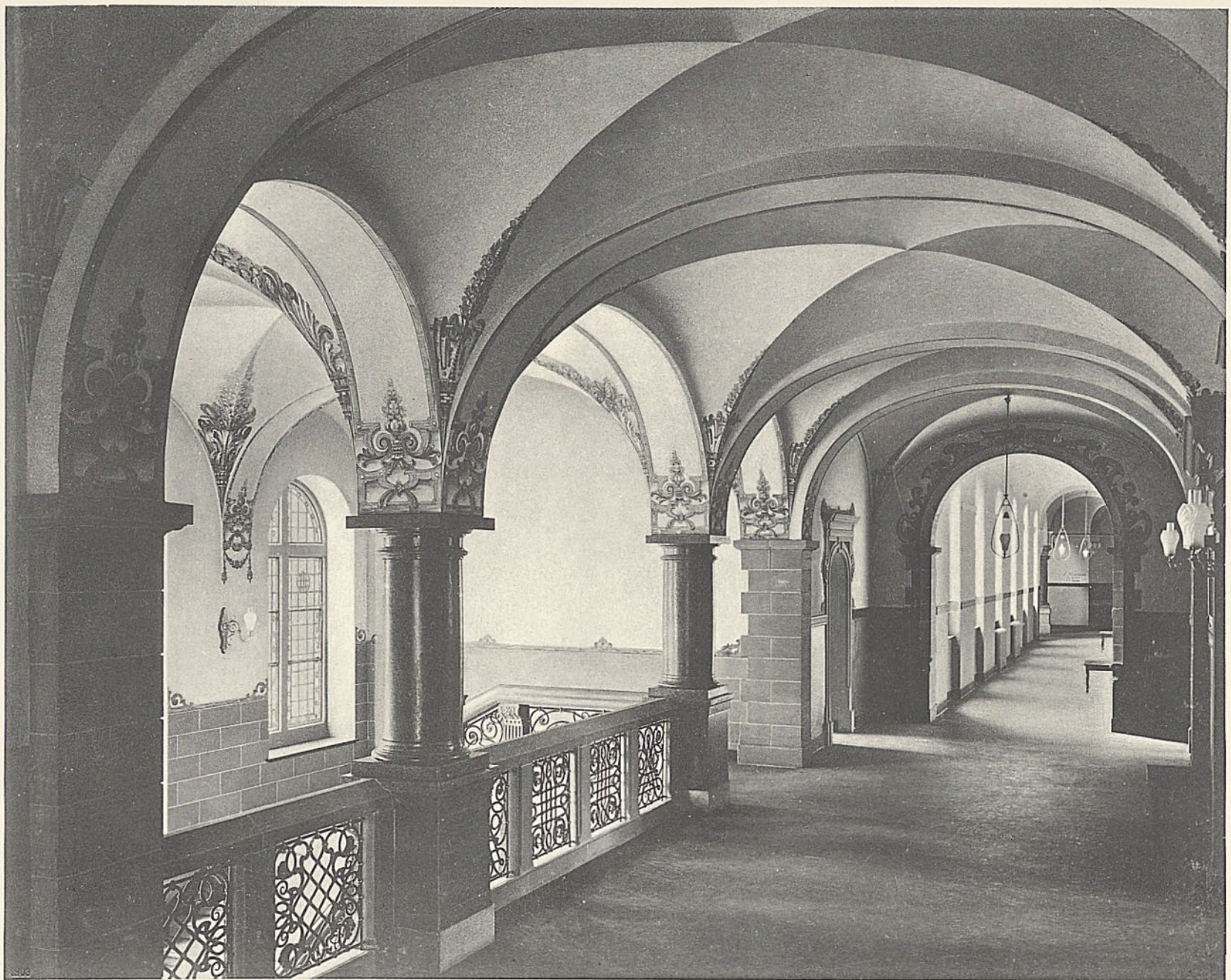
Abb. 1. Flur im ersten Stockwerk mit Blick in das Haupttreppenhaus.
