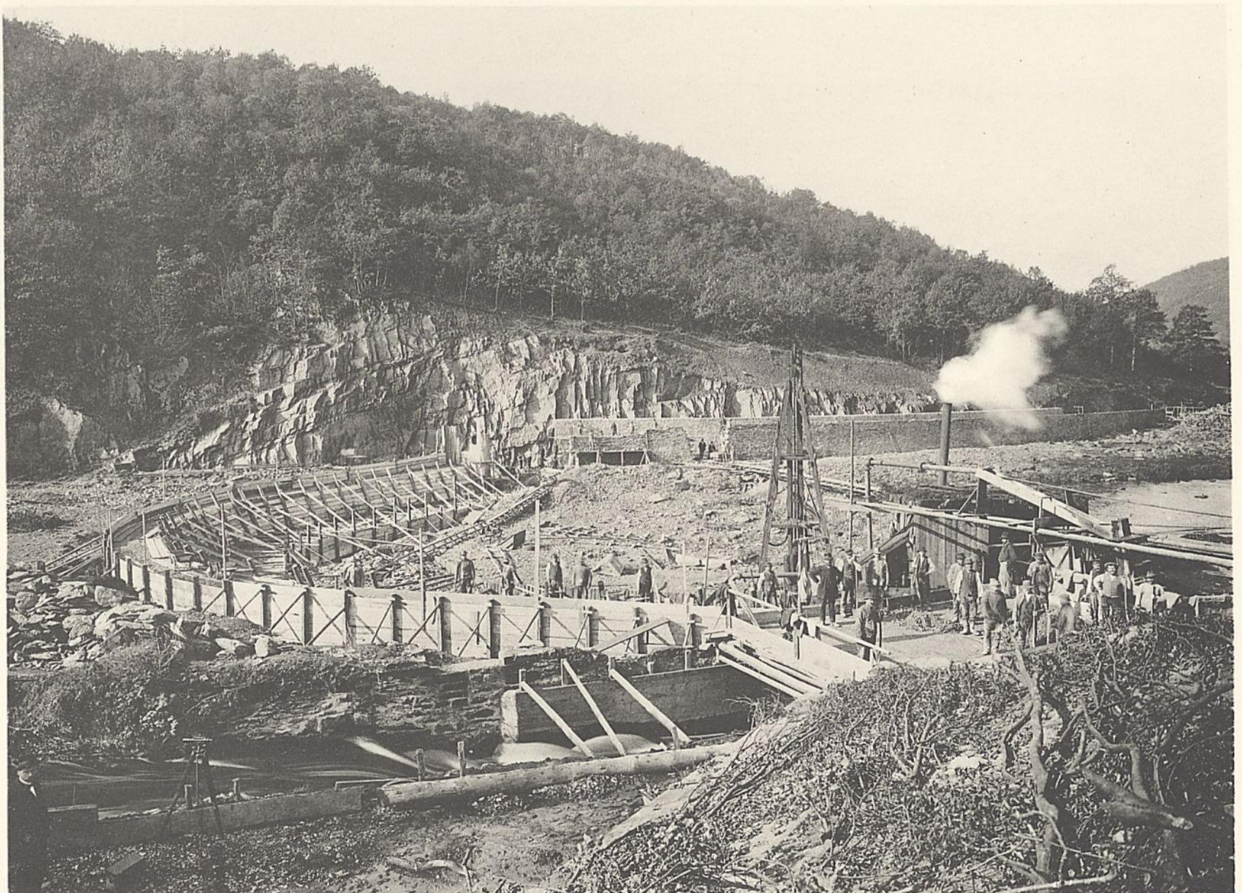
Abb. 2. Bau des Wehrs in der Wupper bei Neuenkotten.
