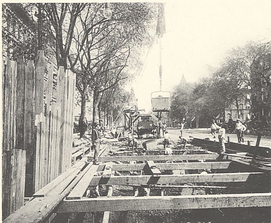
Abb. 4. Bauausführung der Tiefbahn. Beförderung der Erdmassen mit Seilbahn.
