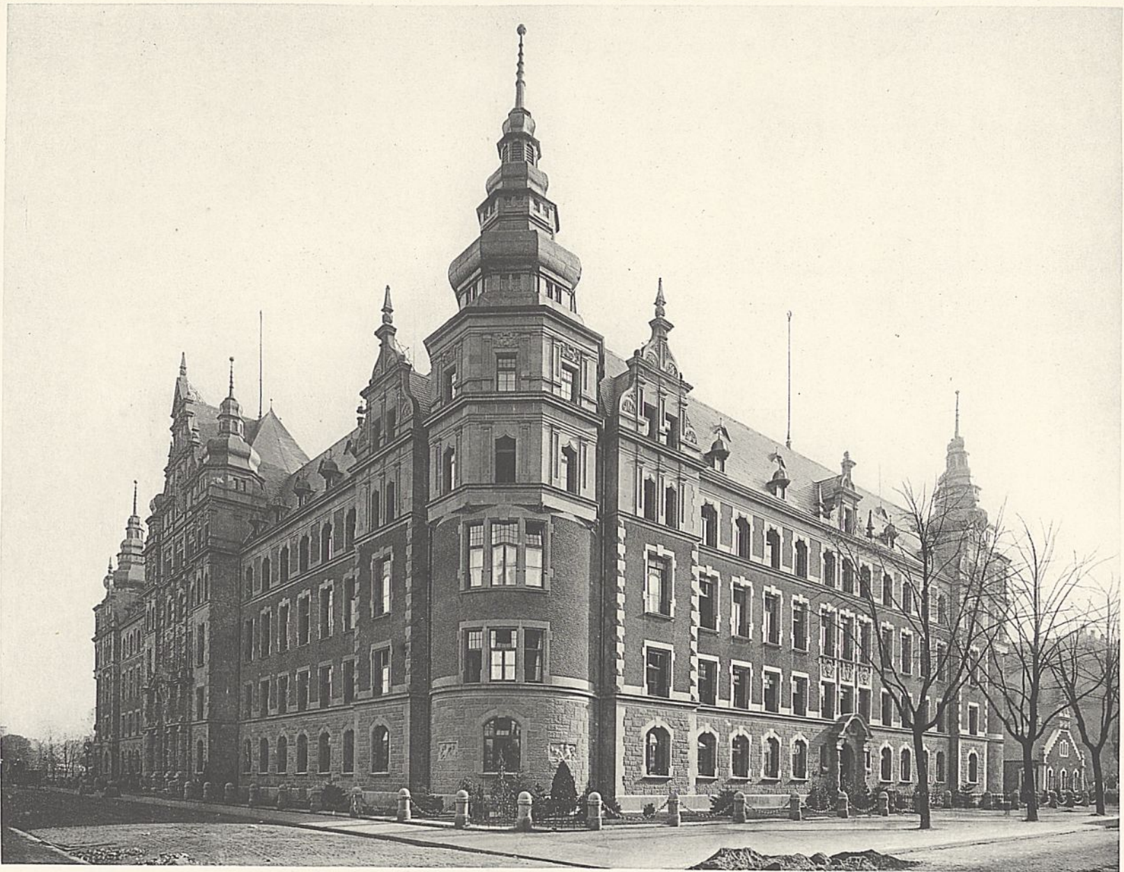
Abb. 1. Eckansicht der Nord- und Westseite.
