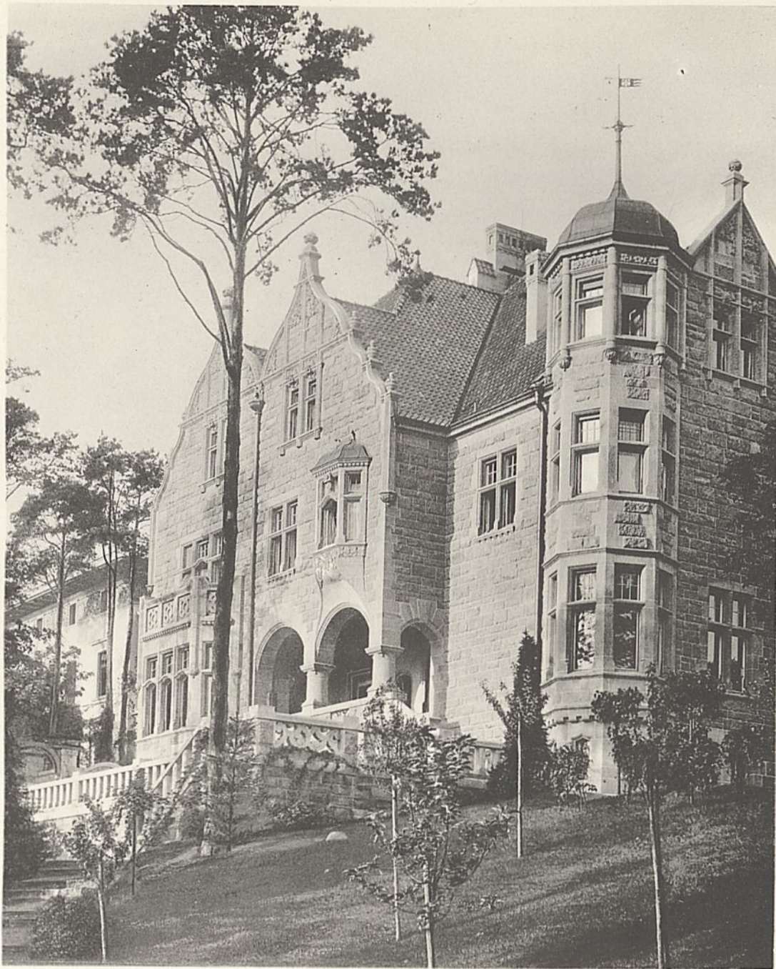
Abb. 1. Ansicht von Osten.
