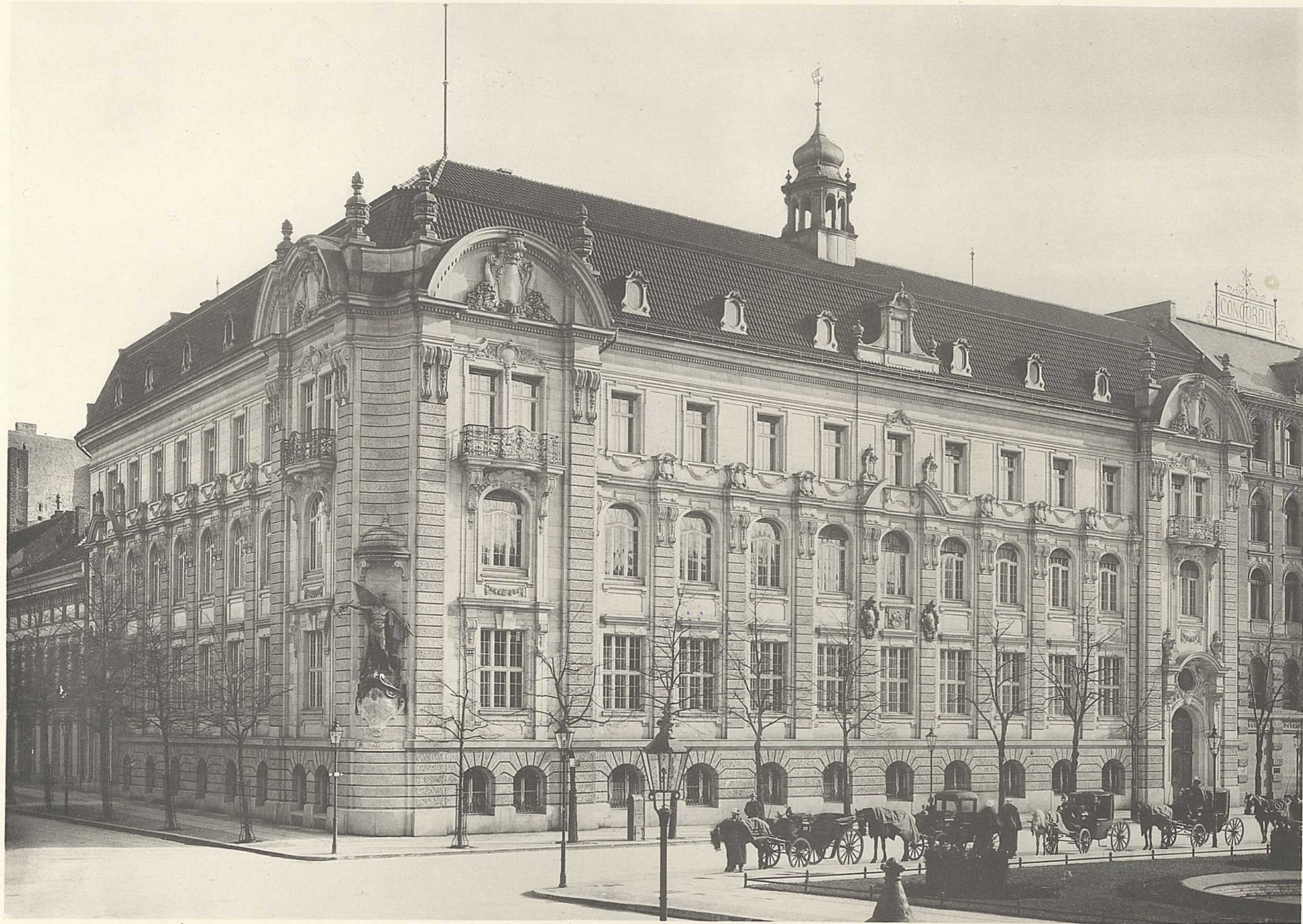
Architekt P. Kieschke.
