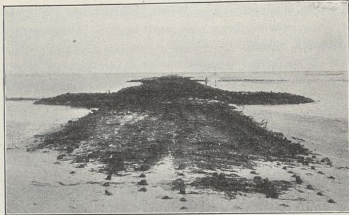
Abb. 13. Ansicht der fertigen Buhne IV. Vom Strande aus gesehen.
