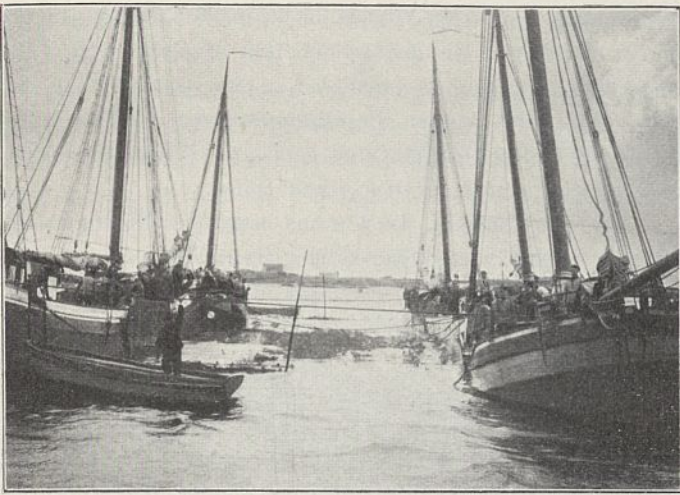
Abb. 12. Senkstück im Augenblick des Absenkens.
