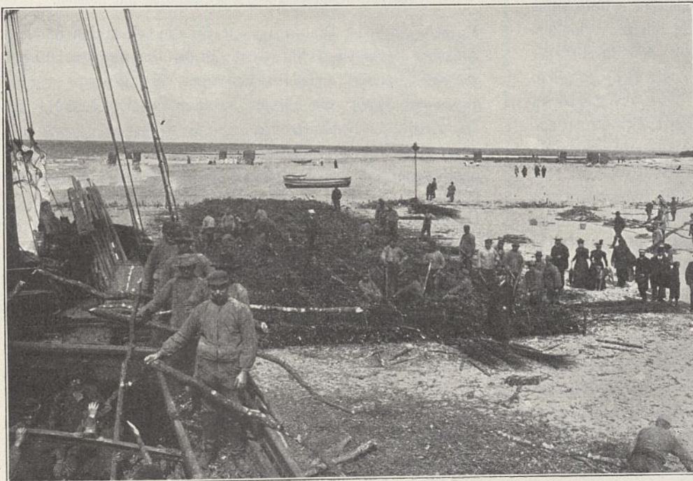
Abb. 9. Binden eines Senkstückes am Niedrigwasserstrande.
