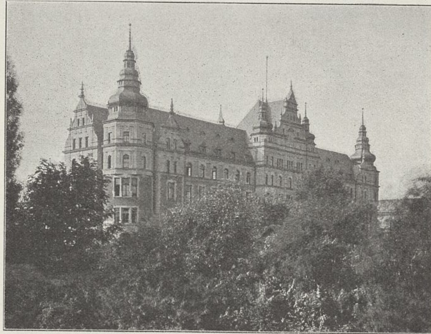
Abb. 1. Ansicht von Nordosten.
