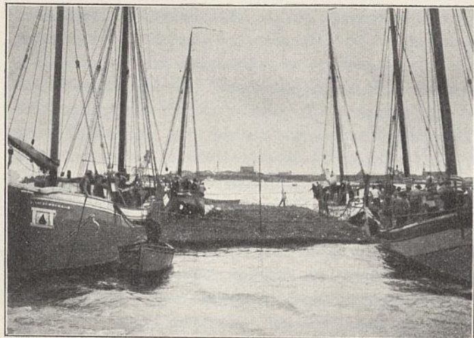
Abb. 11. Senkstück vor der Belastung mit Steinen.
