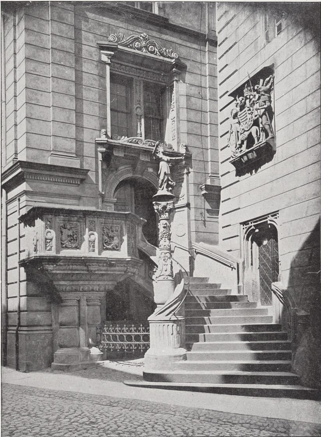
Der Treppenaufgang des Rathauses in Görlitz
