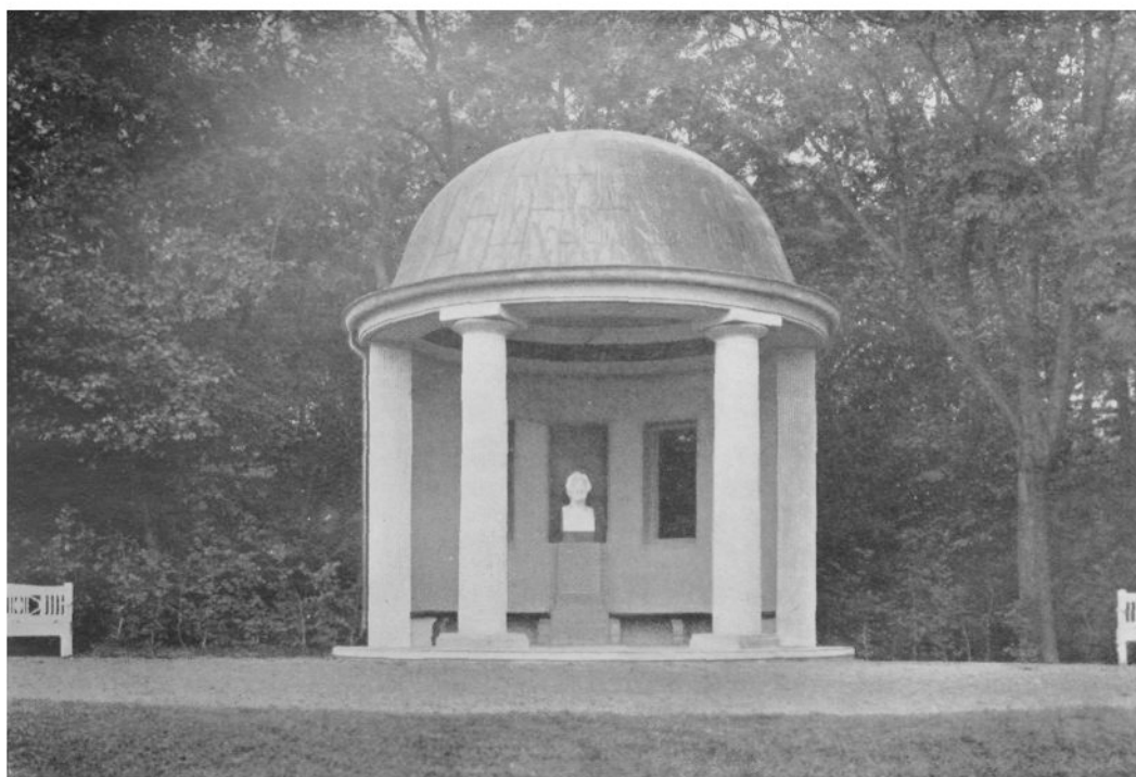
Goethe-Pavillon in Glogau von Stadtbaurat Wagner in Glogau
