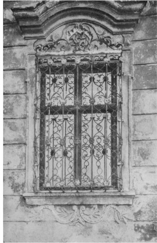
Gitterfenster im Erdgeschoß des Hauses Ring Nr. 27 in Lewin
