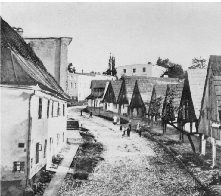
Laubenreihe am Anfang der Grulicher Straße in Mittelwalde
