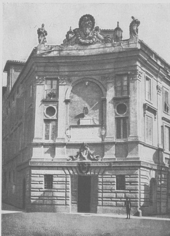
Abb. 216. Rom, Palazzo del Banco di S. Spirito.
