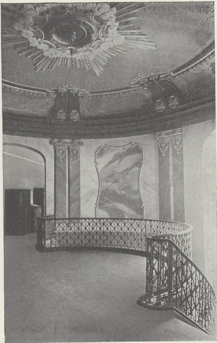
Abb. 16. Gebäude für die Oberstaatsanwaltschaft in Breslau. Haupttreppe im Obergeschoß.
