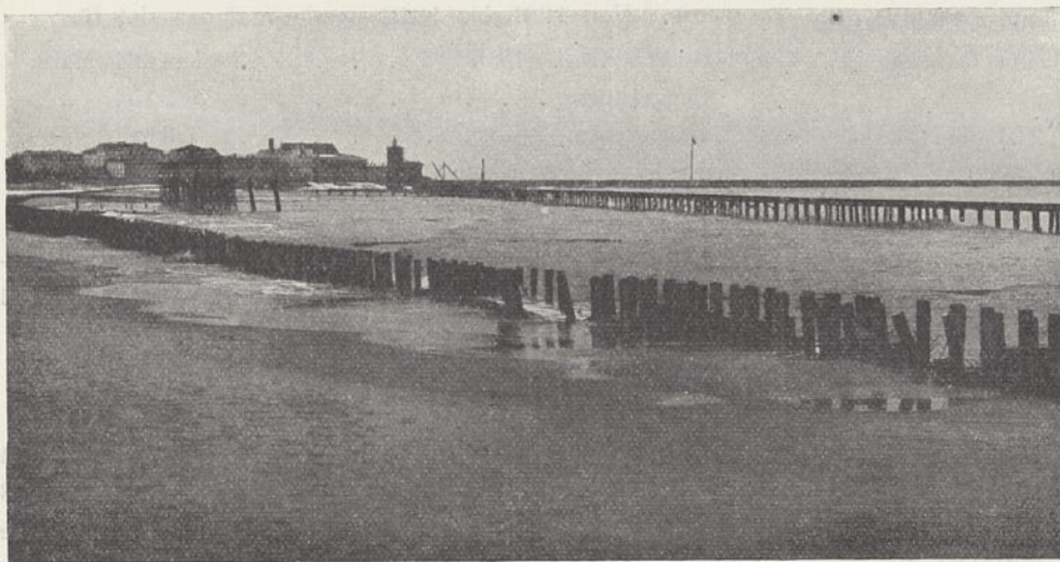
Abb. 14. Zerstörungen des Parallelwerks.
