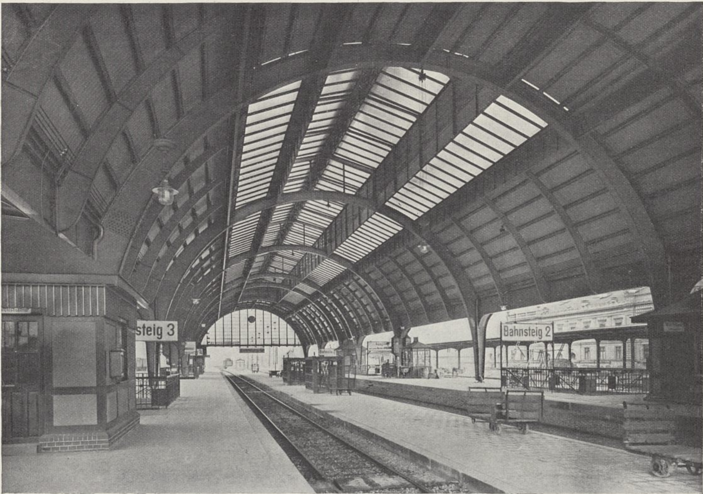
Abb. 1. Bahnhofshalle des preußischen Bahnhofs in Gera.
