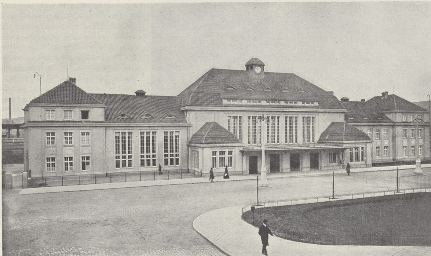
Abb. 3. Empfangsgebäude des sächsischen Bahnhofs in Gera.
