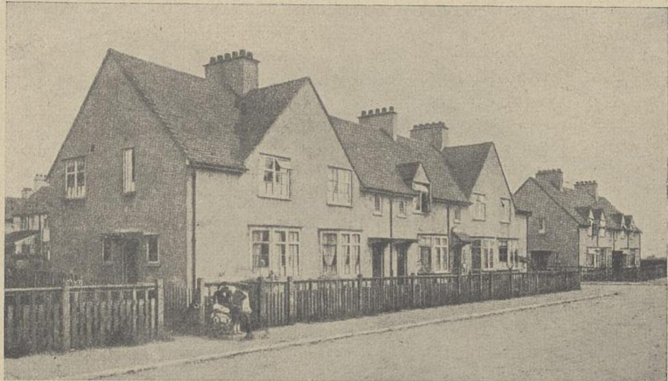
Abb. 79. Häuser aus Betonblöcken in Crayford, Kent.
