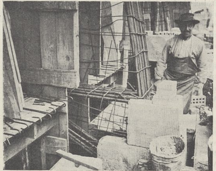
Abb. 22. Eiseneinlage eines Binders über der Volksschwimmhalle mit Eiseneinlage der Galerie.
