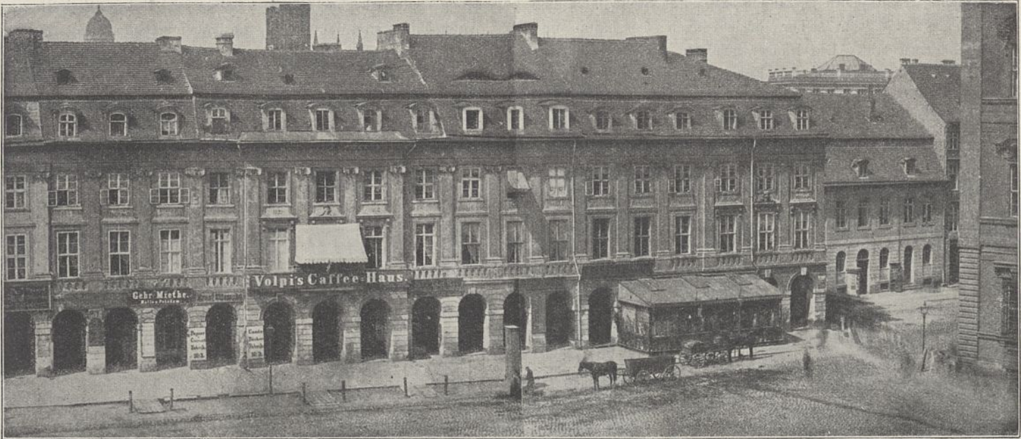
Abb. 41. An der Stehbahn (abgerissen): rechts Durchgang zur früheren Schloßfreiheit, rechts vorn das Königl. Schloß.
