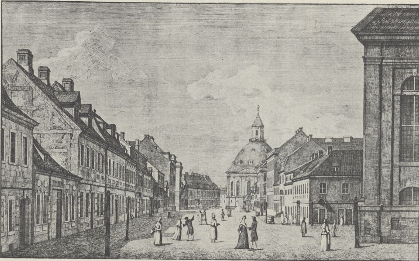
Abb. 47. Blick in die Mauerstraße (im Hintergrunde die Dreifaltigkeitskirche) (nach einem Kupferstich von Rosenberg).
