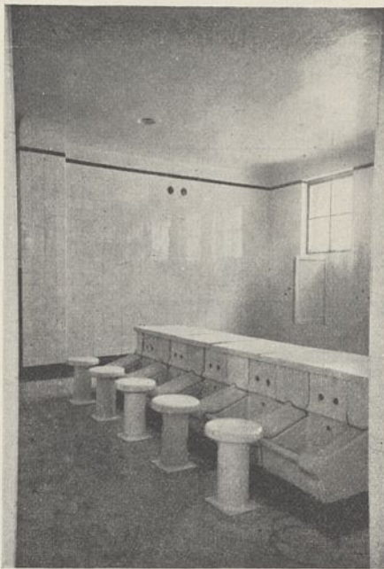
Abb. 6. Fußwanne in dem Reinigungsraum der Männerschwimmhalle.
