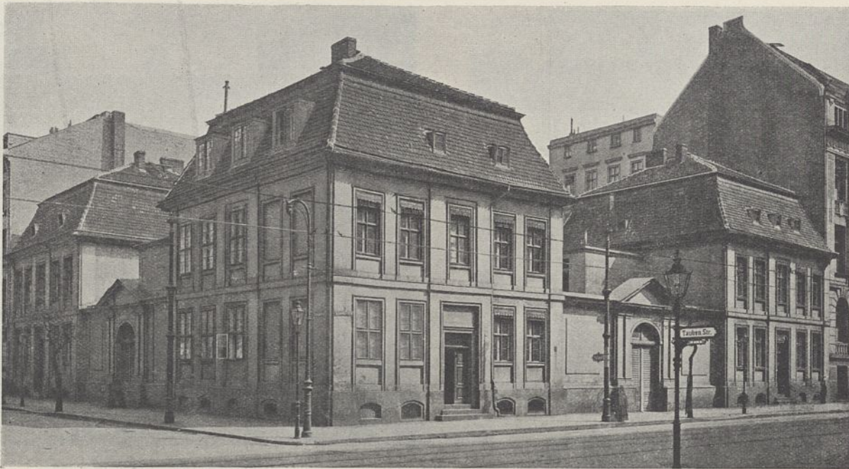
Abb. 54. Kanonierstraße 4/5, Ecke Taubenstraße (Predigerhäuser der Dreifaltigkeitskirche).
