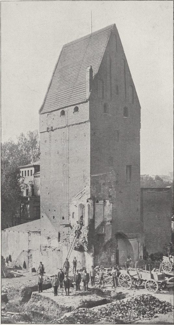
Mauerturm bei der neuen Pforte auf dem Grundstück des neuen Rathhauses abgebrochen im Jahre 1902.
