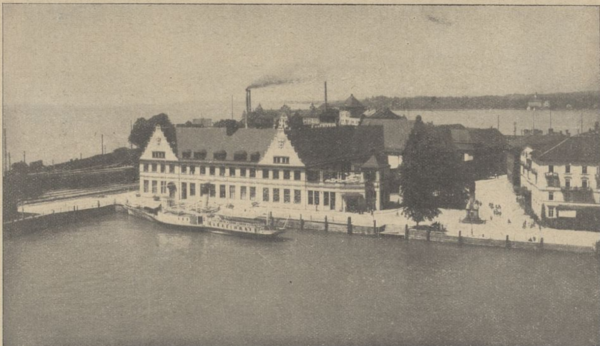
Abb. 2. Empfangsgebäude Bahnhof Lindau, Ansicht vom Hafen.
