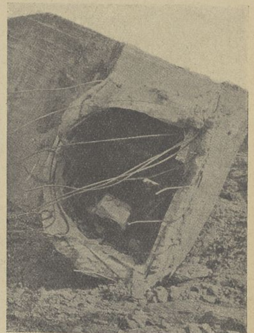
Abb. 22. Zerstörter Grundablaß.
