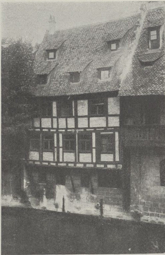
Abb. 9. Lagerhaus, alter Zustand.
