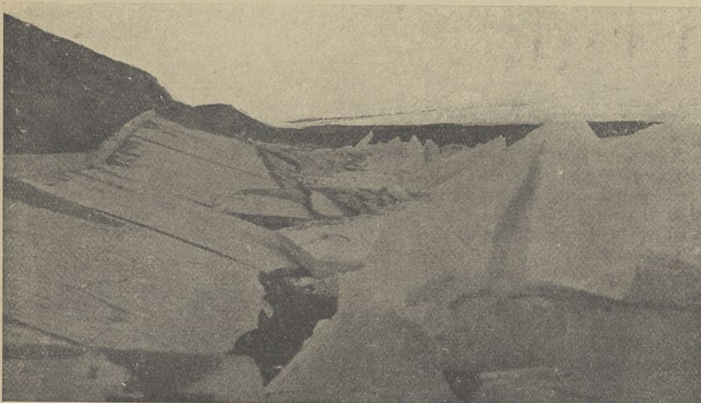
Abb. 21. Zerstörte Böschungsbefestigung.
