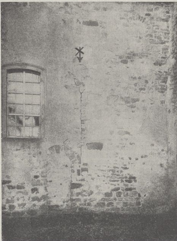
Abb. 23. Leitzkau, Dorfkirche. Nordostecke der ursprünglichen Kirche in der jetzigen nördlichen Chormauer.
