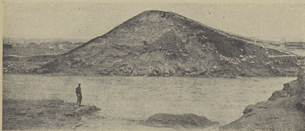
Abb. 27. Hebron-Damm, Bruchstelle im Dammquerschnitt.
