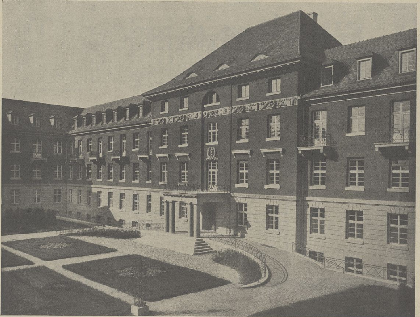
Abb. 1. Heidelberg, Medizinische Klinik, Blick auf den Mittelbau des Vorhofes.
