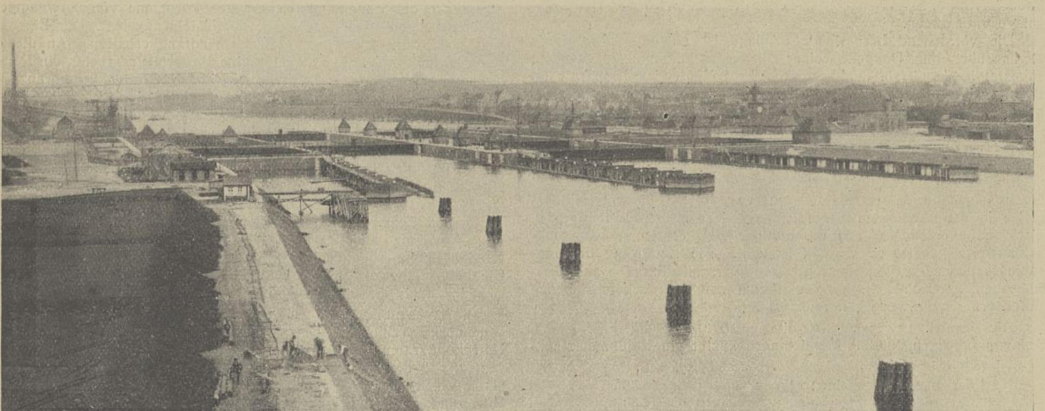
Abb. 81. Ueberblick über die fertigen Schleusen nebst Vorhäfen.
