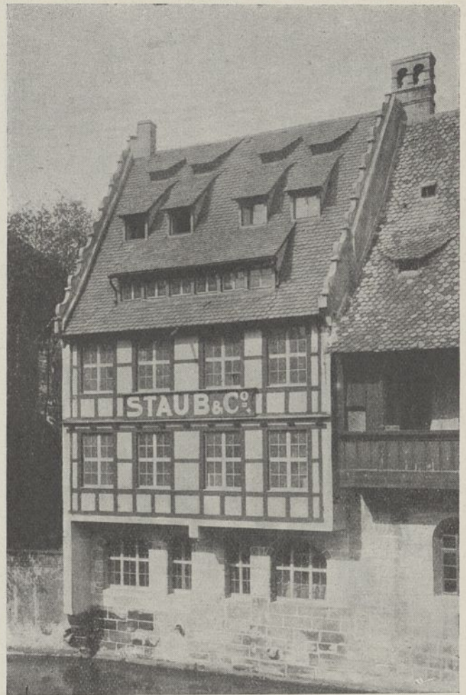
Abb. 10. Lagerhaus nach dem Umbau.
