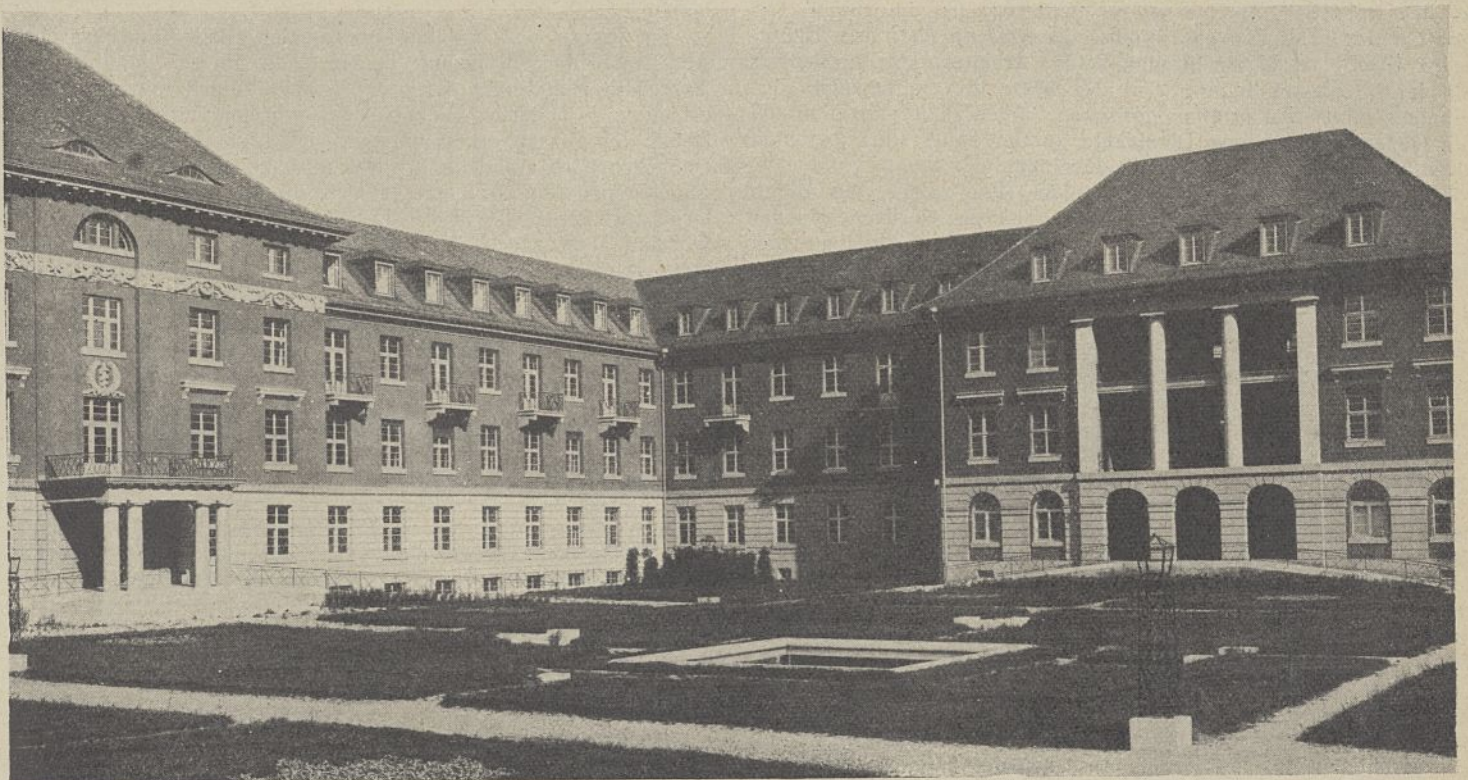
Abb. 5. Heidelberg, Medizinische Klinik, Vorhof mit Mittelbau und östlichem Seitenflügel.
