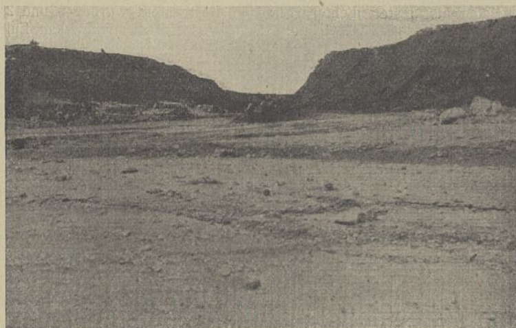
Abb. 31. Ansicht der Bruchstelle. Abb. 29—30. Hatchtown-Damm.
