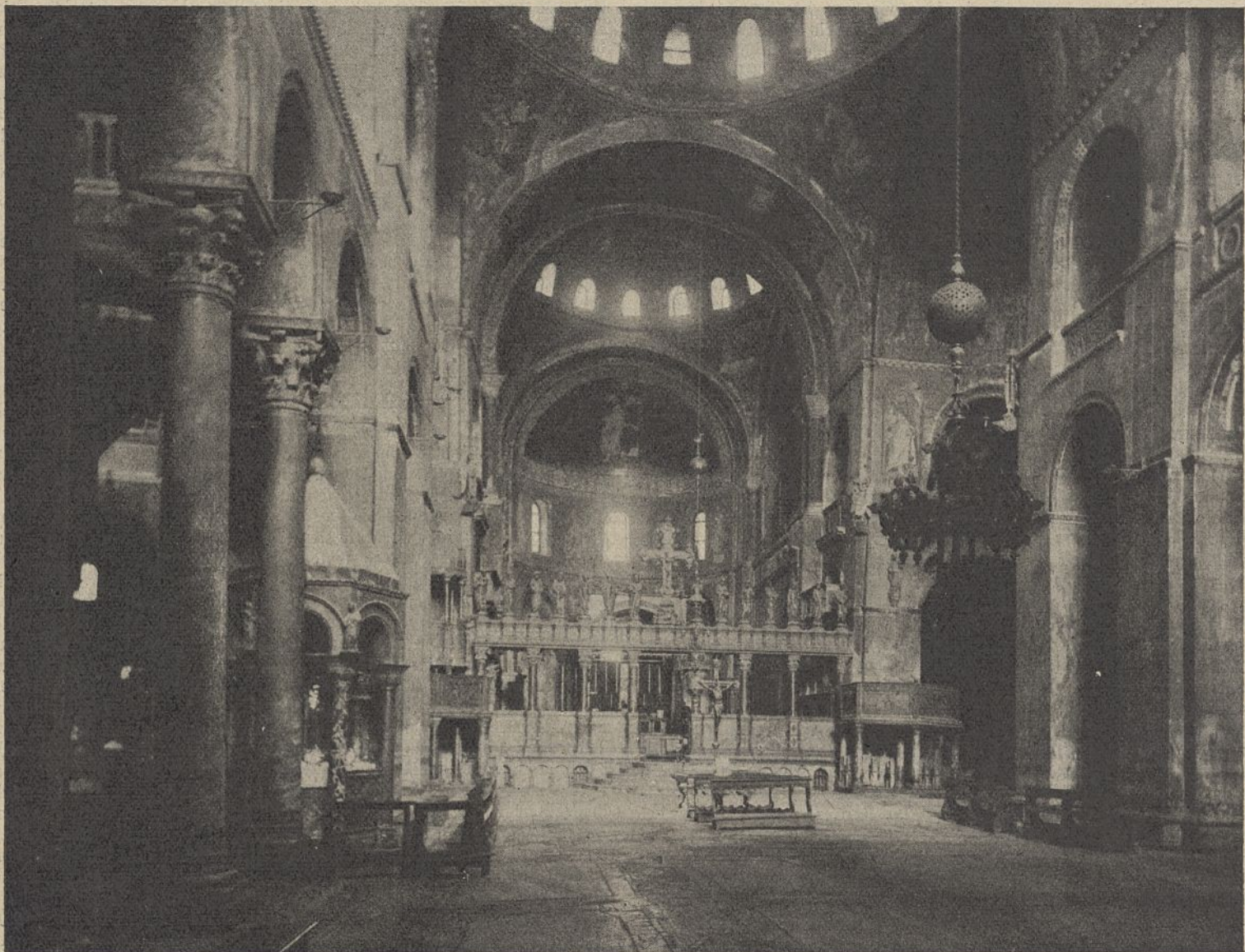
Abb. 1. San Marco in Venedig, Innenansicht etwa vom Haupteingange aus.
