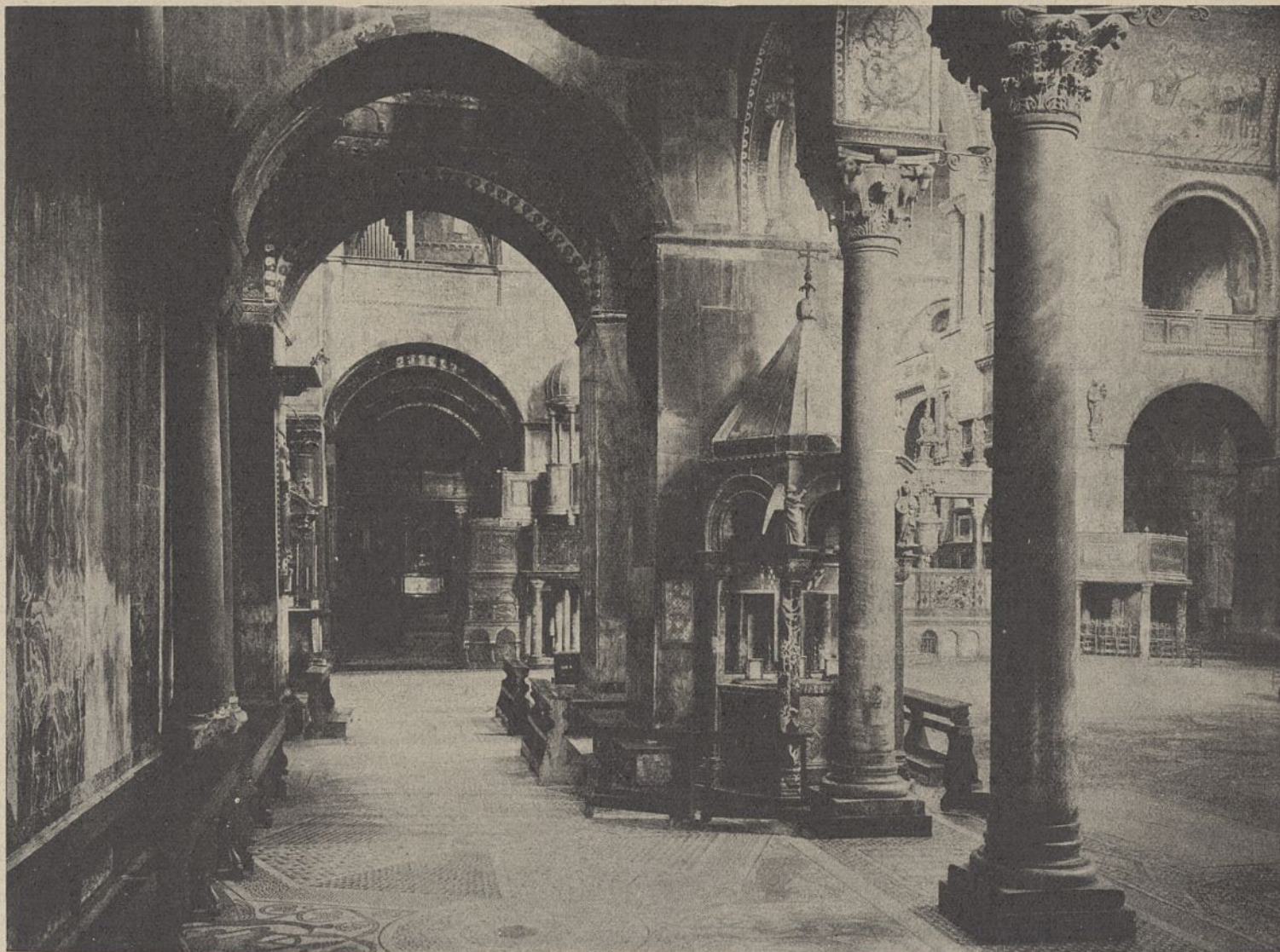
Abb. 6. San Marco in Venedig, Blick durch den nordwestlichen Vierungspfeiler.
