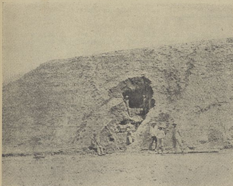
Abb. 28. Hebron-Damm, Ausspülung am Damm.
