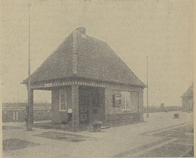
Abb. 80. Schleusenmeisterhaus auf der Mittelmauer.
