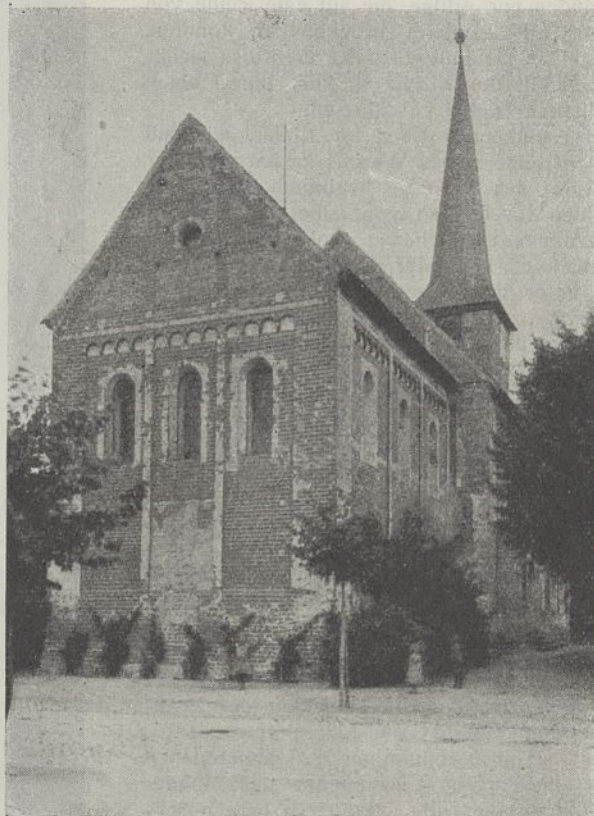
Abb. 15. Jerichow, Pfarrkirche von Nordosten.
