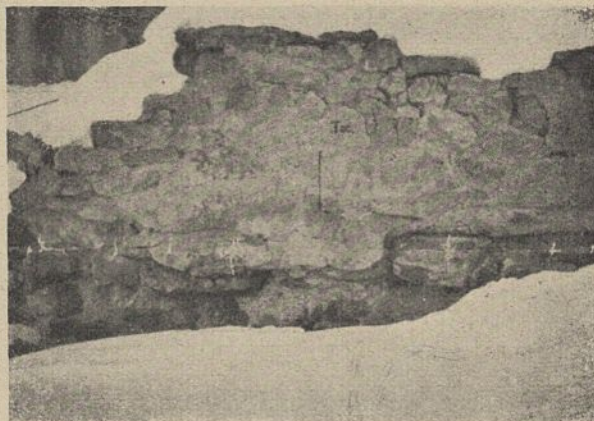
Abb. 8. Pfeileruntermauerung (Pfeiler 12), Seitenansicht gegen Pfeiler 13 hin gesehen.
