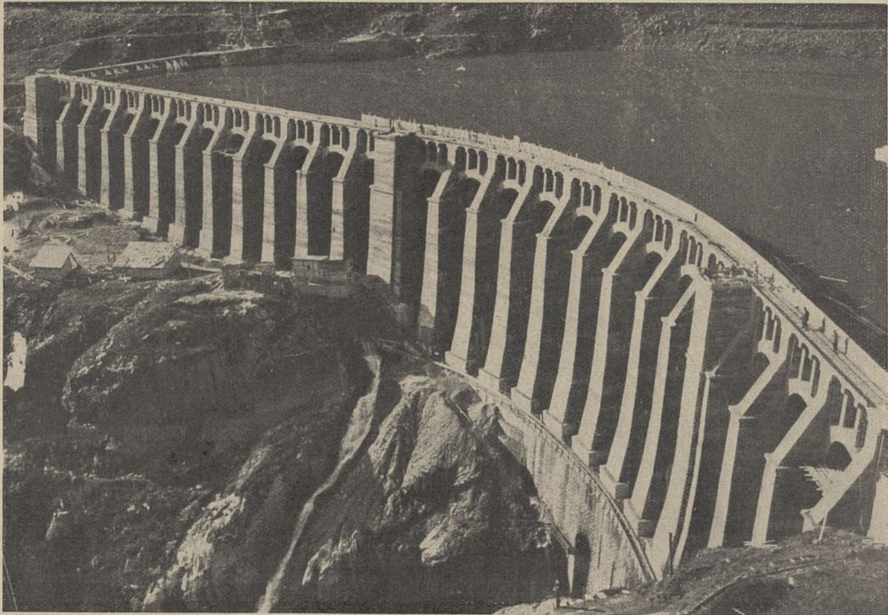
Abb. 1. Die Gleno-Talsperre, nach Fertigstellung.
