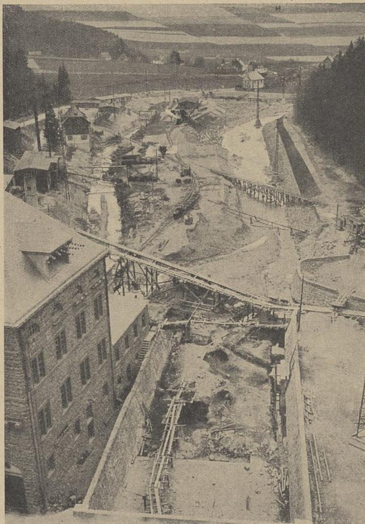
Abb. 8. Blick von der Mauer auf die Baustelle des Ausgleichweihers am 14. April 1923.
