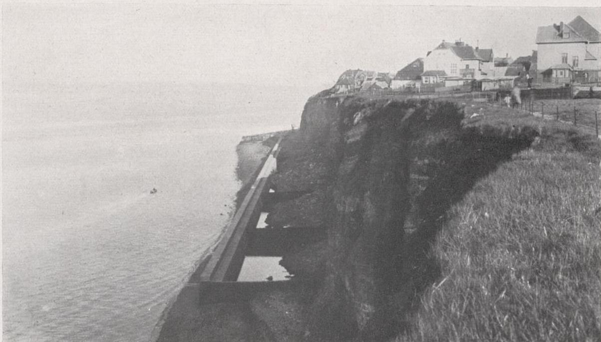
Abb. 17. Fertige Schutzmauer mit den Häusern des Oberlandes.
