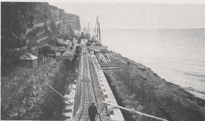
Abb. 10. Fertige Mauer mit teilweise verlegten Abdeckplatten.
