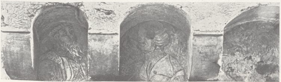
9. Die Bilder zwischen den Kragsteinen des oben dargestellten Vorbaus vor der Wiederherstellung.
