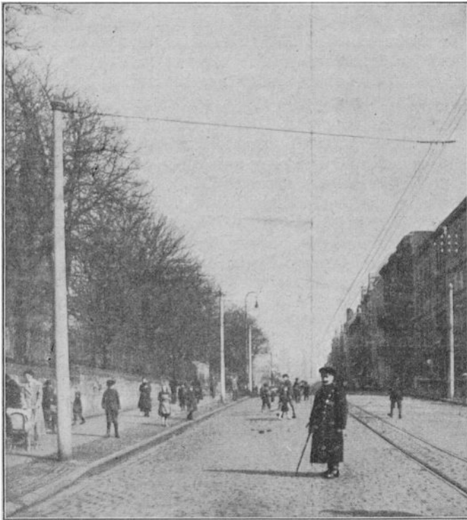
Abb. 2. Eisenbetonmaste von minderwertiger Beschaffenheit. Aufgestellt 1919.
