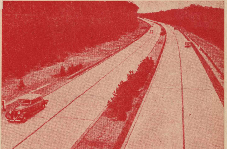
Odcinek państwowej drogi samochodowej w Niemczech na szlaku Frankfurt n/M - Darmstadt
