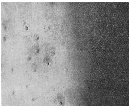
Rys. 5. Widok wewnętrznej strony wycinka rury, wyjętej z ekonomizera po blisko roku pracy przy użyciu wody odgazowanej, lecz niedostatecznie.
